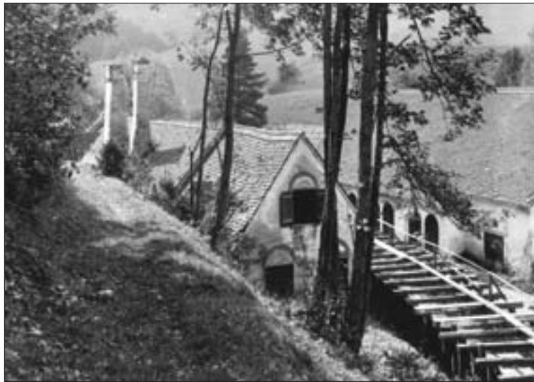
Abb. 13: Die beiden Werks-gaden des aufgelassenen Sensenhammers in Warbach zu beiden Seiten des Fluders bald nach 1930. Foto: Bundesdenkmalamt, Landeskonservatorat für Steiermark.
