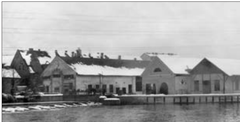
Abb. 8: Gebäude des ehemaligen Sensenwerkes bei der Magdalenen-Kirche in Judenburg. Aufnahme: H. J. Köstler, März 1971.
