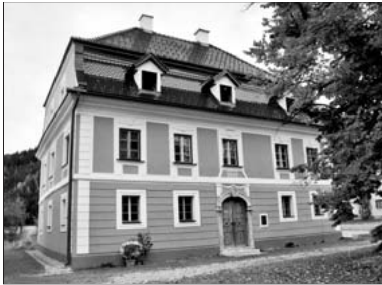
Abb. 15: Herrenhaus des ehemals Stögmüller'schen Sensenwerkes in Hopfgarten bei Weißkirchen, bez. „1788“. Foto: H. J. Köstler, Oktober 2006.
