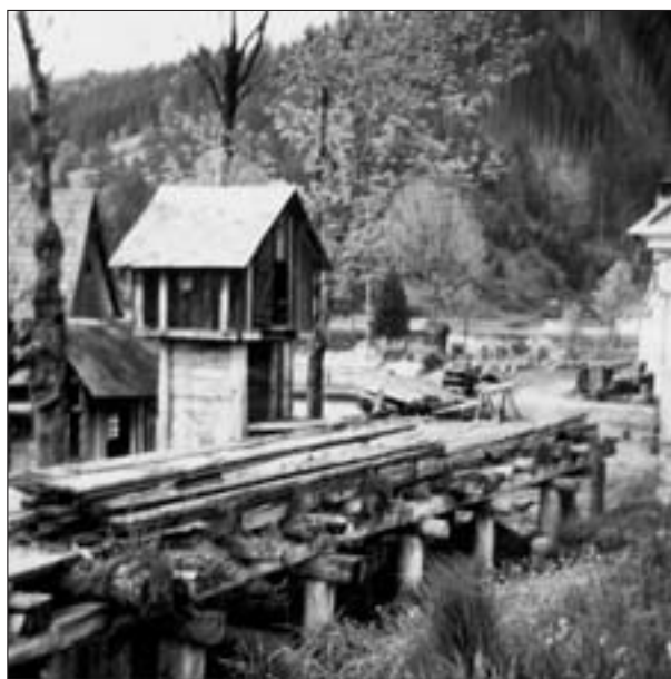
Abb. 20: Reste des 1966 durch Hochwasser beschädigten Fluters bei der Kathal-Schmiede. Aufnahme: H. J. Köstler, Mai 1967.
