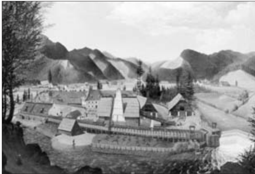
Abb. 2: Die Hüttenanlage der Familie Franz Xaver Edler von Neuper am Pölsbach, OG Möderbrugg. Im Vordergrund Pölsbach mit abgeleiteten Fluter; rechts der Bildmitte: Kohlenbarren; in der Bildmitte: „Leopold-Hochofen“, links dahinter: Herrenhaus; am linken Bildrand: Frischhütte mit Hammerwerk. Gemälde von J. A. Leitner, um 1840, im Besitz von Alfred R. Neuper.
