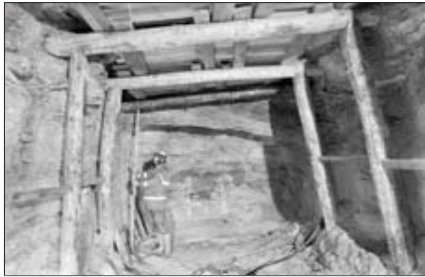
Abb. 6: Grube Kleinfeldstritz: Vorbereitung von Zimmerarbeiten heute.
