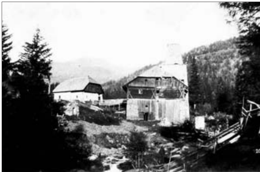
Abb. 2: Hüttengebäude mit Hochofen in der Schmelz (Seetaler Alpen), wahrscheinlich um 1900. Fluter, Radstube und Wasserrad sowie Kohlbarren bereits abgetragen. Undatierte Aufnahme im Museum der Stadt Judenburg (siehe auch auf Seite U4).
