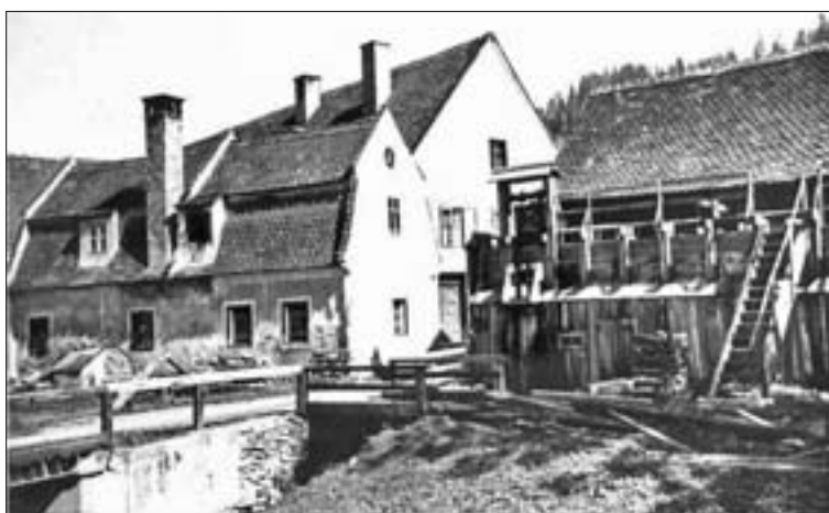
Abb. 19: Kathal-Schmiede, um 1930 (vgl. Abb. 18). Rechts: Fluter mit Radstube am Hammergebäude, links: Schmiedhaus, dahinter Wohnhaus. Undatierte Aufnahme im Bundesdenkmalamt, Landeskonservatorat für Steiermark, Graz.
