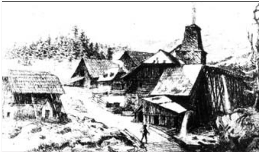
Abb. 1: Hochofenanlage in der Schmelz (Seetaler Alpen), wahrscheinlich um 1860. Rechts: Hüttengebäude mit Hochofen, aufgeständertem Fluter und Radstube (Wasserrad nicht sichtbar); Bildmitte (hinten): Kohlbarren (und Erzbunker?). Undatierte Zeichnung im Museum der Stadt Judenburg.
