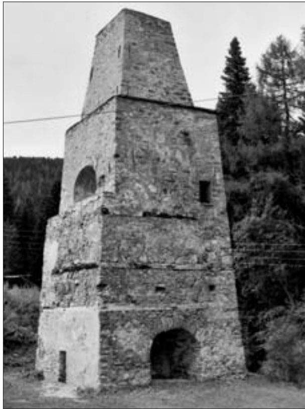
Abb. 3: Hochofen in der Schmelz (Seetaler Alpen), nach Beseitigung des 1982 durch einen Brand zerstörten Gebäudes frei stehend. Vorne unten Blasformgewölbe (mit nicht mehr vorhandener Blasform zum Einblasen von Luft, „Wind“, in den Ofen); oben links Gewölbe für Zufuhr von Erz und Holzkohle (Begichtung). Eigentlicher Ofen (mit metallurgischen Reaktionen) von der (ehemaligen) Hüttensole bis zum ersten Mauerabsatz, darüber Rauchhaube. Aufnahme: H. J. Köstler, September 2006.
