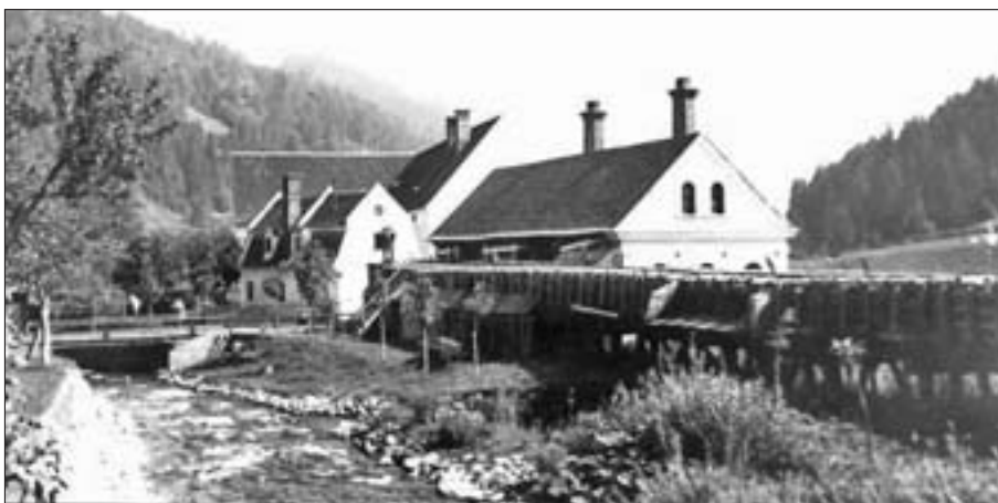
Abb. 18: Kathal-Schmiede bei Obdach, um 1930 (vgl. Abb. 19). Rechts vorne: Fluter vom Granitzen-Bach; Bildmitte: rechts Hammergebäude, links Schmiedhaus. Undatierte Aufnahme im Bundesdenkmalamt, Landeskonservatorat für Steiermark, Graz.
