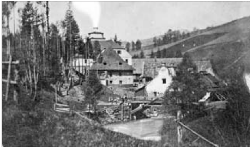
Abb. 2: Die Hüttenanlage der Familie Franz Xaver Edler von Neuper am Pölsbach, OG Möderbrugg, um 1880. Undatierte Fotografie im Besitz von W. Neuper. Links: Herrenhaus, dahinter „Francisci-Hochofen“; rechts: Frischhütte und Hammerwerk, dahinter Kohlbarren.
