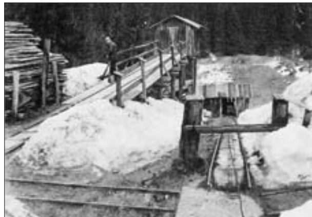
Abb. 2: Fördereinrichtungen am Stollenmundloch „Erika“ um 1950.
