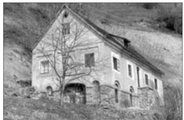
Abb. 6: Spitalhaus (Bergspital) mit Mundloch des Förderstollens. – Foto H. Schenn 2001 (siehe Abb. 3).
