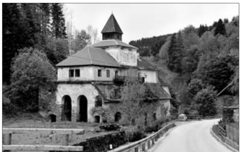
Abb. 8: Hochofenanlage „Pfannerhütte“ in Mosinz. In der Mitte des Hüttengebäudes steht der Hochofen (jetzt mit Pyramidendach), links Aufzugshaus, rechts Gebläsehaus; zwischen Hüttengebäude und Mosinzer Bach (bzw. Straße) Radstube (für Wasserräder). Aufnahme: H. J. Köstler, Mai 2006.
