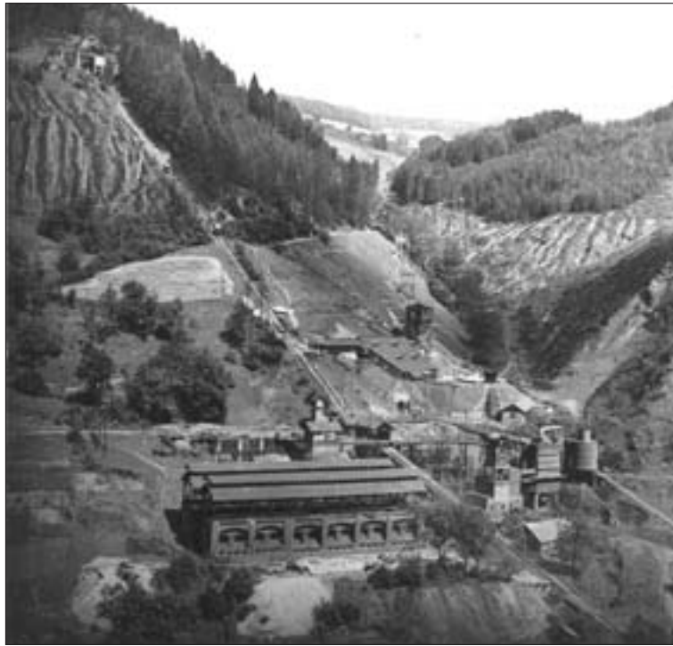
Abb. 20: Globitschbremse und Erzröstanlage in Hüttenberg um 1935. Im Mittelgrund Globitschbremse (links) sowie Materialeilbahn und Erzbunker; darunter das Mundloch des Erzabzugsstollens, das 1954 beim Vortrieb des Unterfahrungsstollens benützt wurde. Im Vordergrund die zwischen 1908 und 1915 erbaute, zuletzt zwei Batterien mit je sechs Öfen umfassende Röstanlage (Schachtföfen mit Mischbegichtung) sowie rechts die Apold-Fleißner-Röstanlage (Betriebsbeginn 1927). Undatierte Aufnahme im Besitz von H. Schenn.
