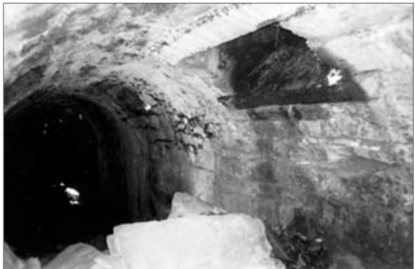
Abb. 3: Abzugsstollen (Sohlstollen) mit Füllschnauze (rechts) im Barbara-Erzkasten. Aufnahme: H. J. Köstler, Mai 1999.
