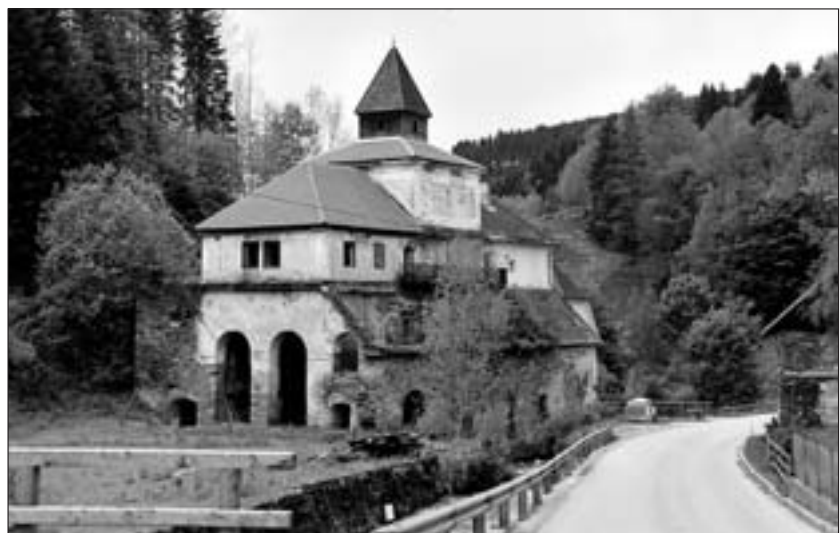
Abb. 8: Hochofenanlage „Pfannerhütte“ in Mosinz. In der Mitte des Hüttengebäudes steht der Hochofen (jetzt mit Pyramidendach), links Aufzugshaus, rechts Gebäulichhaus; zwischen Hüttengebäude und Mosinzer Bach (bzw. Straße) Radstube (für Wasserräder). Aufnahme: H. J. Köstler, Mai 2006.
