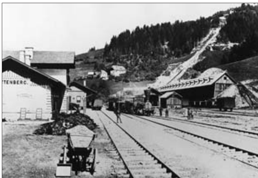
Abb. 3: Bahnhof Hüttenberg (links), Bahnlinie nach St. Veit a. d. Glan (Mitte) sowie Globitsch-Bremsberg und (alte) Erzverladeanlage (rechts, vgl. Abb. 12) um 1875. Aufnahme: Bildarchiv H. J. Köstler (Nachlass W. Schuster).
