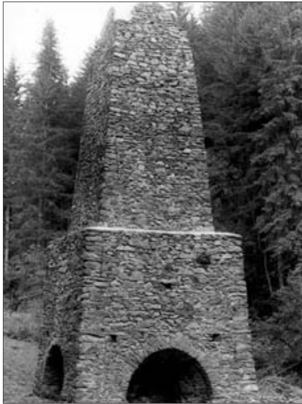
Abb. 7: Fuchsfloßofen. Ofenstock mit Blasformgewölbe (vorne) und Abstichgewölbe (links); Rauchhaube (mit nicht sichtbarem Begichtungsgewölbe). Aufnahme: H. J. Köstler, Juni 1984.
