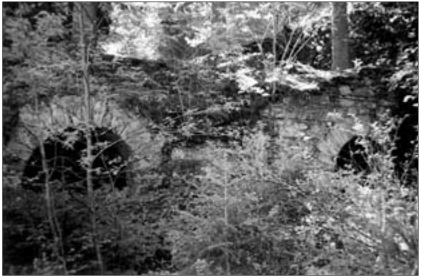
Abb. 2: Barbara-Erzkasten in Staining an der Erzbahn zwischen Andreaskreuz-Bremse bzw. Barbara-Stollen und Barbara-Bremse. Zwei Abzugsstollen (Sohlstollen) mit Füllschnauzen, vgl. Abb. 3. Aufnahme: H. J. Köstler, Mai 1999.
