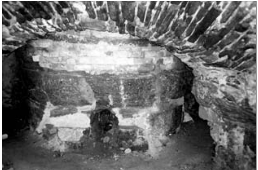
Abb. 14: Unterer Bereich („Gestell“) des Johanna-Ofens im Ofenstock. Aufnahme: H. J. Köstler, September 1997.
