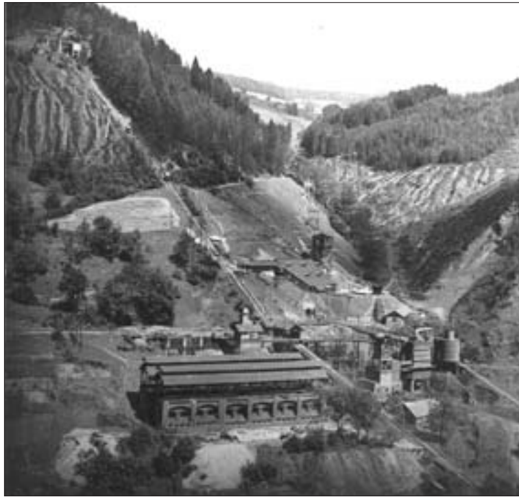
Abb. 20: Globitschbremse und Erzröstanlage in Hüttenberg um 1935. Im Mittelgrund Globitschbremse (links) sowie Materialeilbahn und Erzbunker; darunter das Mundloch des Erzabzugsstollens, das 1954 beim Vortrieb des Unterfahrungsstollens benützt wurde. Im Vordergrund die zwischen 1908 und 1915 erbaute, zuletzt zwei Batterien mit je sechs Öfen umfassende Röstanlage (Schachtöfen mit Mischbegichtung) sowie rechts die Apold-Fleißner-Röstanlage (Betriebsbeginn 1927). Undatierte Aufnahme im Besitz von H. Schenn.
