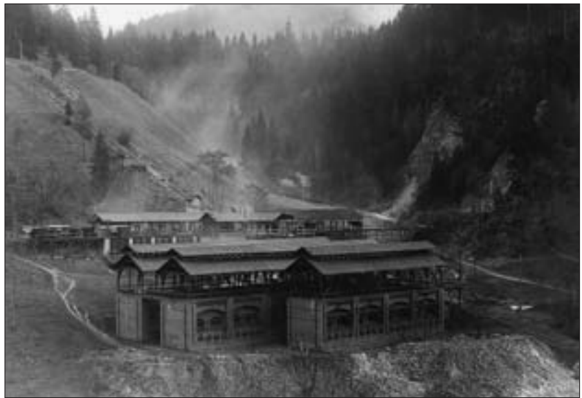
Abb. 11: Erzröstanlagen am Fuß des Globitsch-Bremsberges beim Hüttenberger Erzberg. Im Vordergrund drei Batterien mit insgesamt 16 Schachtröstöfen (Mischbegichtung), davon je acht erbaut 1908/9 und 1914/15; fotografiert zwischen 1915 und 1925. Aufnahme: Bildarchiv H. J. Köstler (Nachlass W. Schuster).
