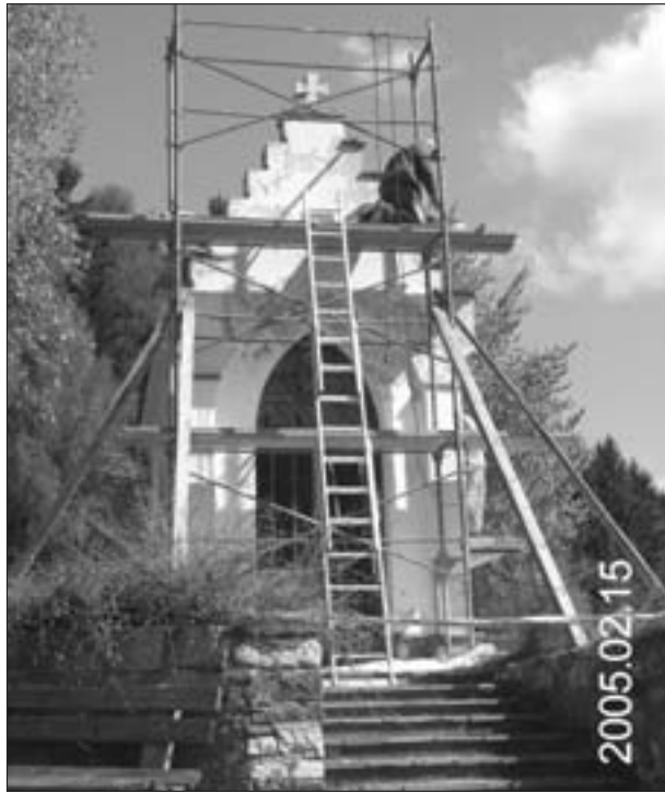
Abb. 9: Kurt Pucher beim Ersetzen der Abdeckplatten. – Foto K. Dieber 2005.
