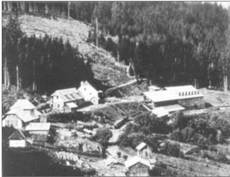
Abb. 4: Staining um 1890. Rechts Barbara-Erzkasten (vgl. Abb. 2) an der Erzbahn zur Barbara-Bremse; links der Bildmitte Grubenhaus des Barbara-Stollens. Undatierte Aufnahme im Besitz von H. Schenn.
