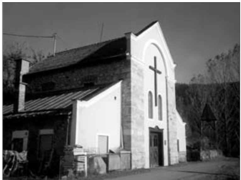
Abb. 23: Ehemaliges Bremshaus der Wilhelmbremse in Knappenberg, zur Barbarakirche umgestaltet und 1928 eingeweiht. Aufnahme: H. J. Köstler, November 1997.
