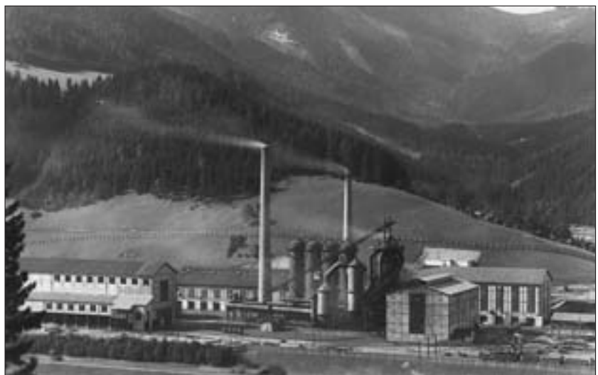
Abb. 10: Hochofenwerk in Eisenerz um 1905. Von links nach rechts: Koksmagazin, dahinter Kessel- und Maschinenhaus; vier Cowper-Winderhitzer; Kokshochofen (I), angeblasen im November 1901, mit Gichtkran und Gichtgasreinigern; quergestellte Gießhalle. Aufnahme: Bildarchiv H. J. Köstler (Nachlass W. Schuster).
