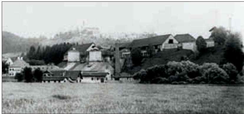
Abb. 7: Hochofenwerk in Treibach um 1885 (?). Links Hüttengebäude mit den zwei 1858/61 erbauten Hochöfen II und III (der veraltete Hochofen I nicht im Bild), dahinter Kohlbarren; rechts: Erzmagazin und Erzröstanlage. Im Hintergrund links Althofen. Aufnahme: Bildarchiv H. J. Köstler (Nachlass W. Schuster).
