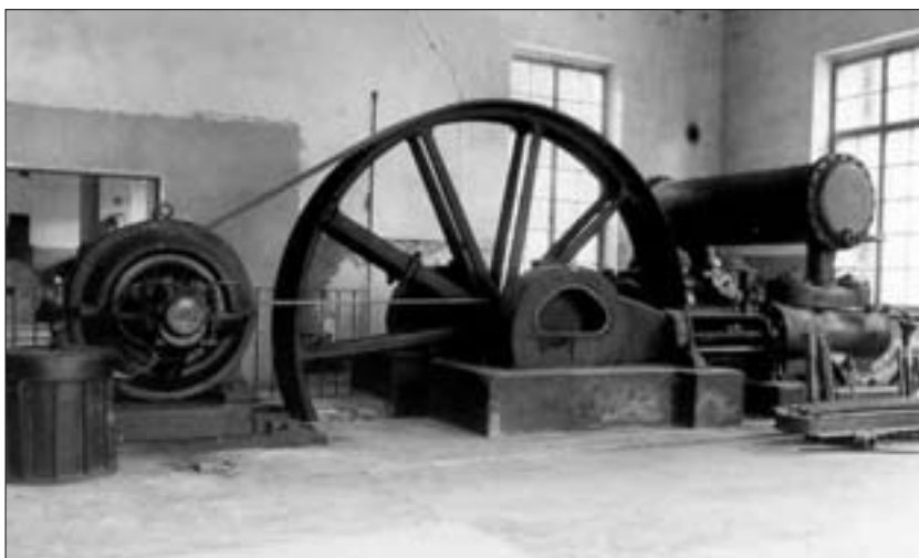
Abb. 18: Kompressor (Baujahr 1917) im Albert-Maschinenhaus (Knappenberg). Aufnahme: K. Dieber, 2001.
