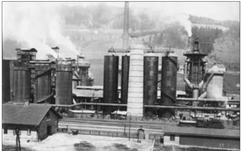
Abb. 9: Hochofenwerk (Kokshochöfen) in Donawitz am 29. April 1906. Von links nach rechts: Hochofen I (angeblasen 1891) mit drei Winderhitzern; Hochofen II (angeblasen 1899); in Bau begriffene Winderhitzer für Hochofen IV (angeblasen 1907); ganz rechts Hochofen III (angeblasen 1905). Aufnahme: Bildarchiv H. J. Köstler (Nachlass W. Schuster).
