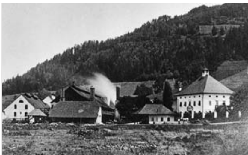
Abb. 8: Stahl- und Walzwerk in Buchscheiden bei Feldkirchen um 1885 (?). Links: Puddelstahlwerk, daneben Puddelstahl- und Walzhütte (davor quergestelltes Magazin); rechts: Wohnhaus des Direktors bzw. des Hüttenverwalters. Aufnahme: Bildarchiv H. J. Köstler.
