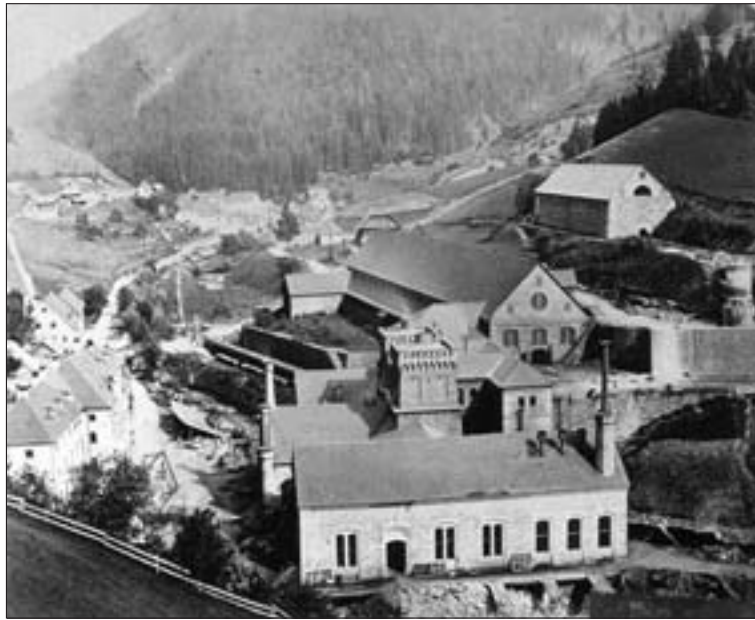
Abb. 9: Hochofen- und Stahlwerk in Heft im Mosinzgraben zwischen 1864 und 1869. Rechts oben Erzkasten, darunter rechts einer der beiden Schwedischen Erzröstöfen; rechts der Bildmitte (unter dem Erzkasten) Kohlbarren; in der Bildmitte Hochofen „Johann-Ernst“ und „Pulcheria“ (vgl. Abb. 10) sowie Bessemerstahlwerk; links Personal- und Verwaltungshaus (vgl. Abb. 11); vorne Gebläsehaus (vgl. Abb. 10). Undatierte Aufnahme im Landesmuseum für Kärnten, Klagenfurt.
