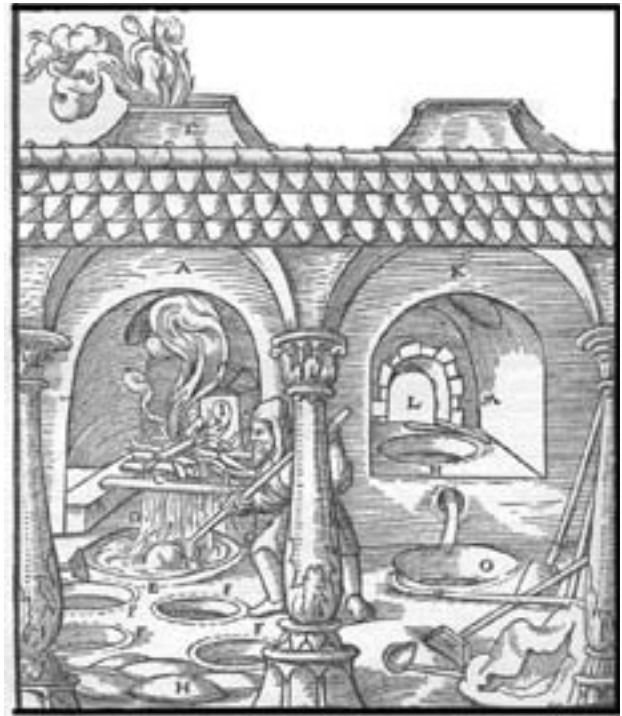
Abb. 4: In „de re metallica libri XII“ des Georg Agricola von 1556 wird ein einfaches Verfahren der Bleigewinnung aus dem Erz mit einem einfachen Feuer auf dem Rost (links) beschrieben. Das Blei sammelt sich in einer Grube unterhalb und wird daraus in runde Formen geschöpft.
