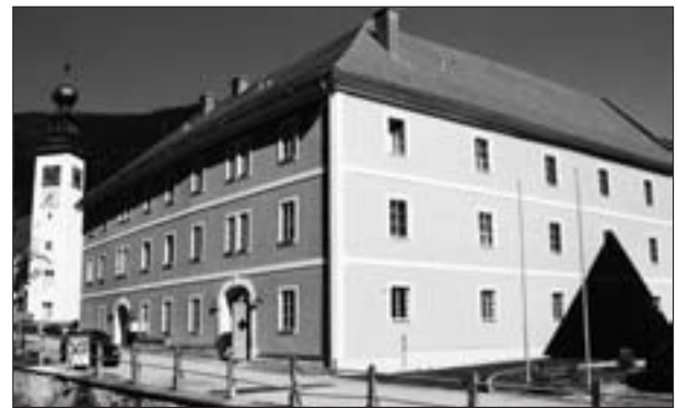
Abb. 4: Kastenhaus in Vordernberg (Viktor-Zack-Straße 1); nach Restaurierung mit Wohnungen sowie mit Ausstellungs- und Informationszentrum der Steirischen Eisenstraße ausgestattet. Aufnahme: Johann Weigl, 1989.
