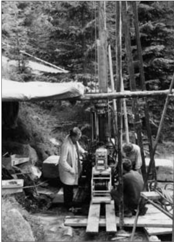
*Abb. 4: Erkundungsbohrung kombiniert mit geophysikalischer Bohrlochvermessung. Aufnahme: F. Prugger, 1985.*
