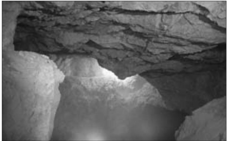
Abb. 8: Blick in einen noch recht kleinen „Abbaukessel“ im System Abbau I im Kienbergrevier des Wilhelm-Erbstollens. Der Durchmesser liegt noch bei etwa 20 m. Links oben der „Weg“, über den der Hauer den Abbauort erreichte. Die höheren Abbauteile gingen am 2.5.1993 zu Bruch.
