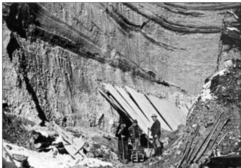
Abb. 14: Feigenstein Anna-Stollen, Sanierungsarbeiten nach dem Wasserausbruch 1955.
