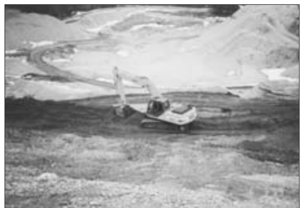
Abb. 10: Rekultivierung der Leiningerhalde
