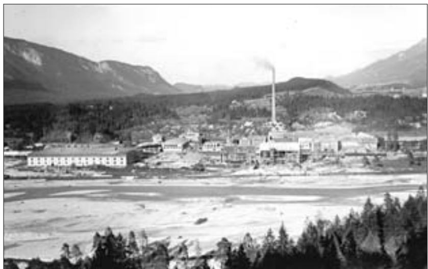
Abb. 17: Blick auf Kärntens größte Baustelle: Der Bau der Zinkelektrolyse in Arnoldstein (ca. 1953) (KLA, BBU).
