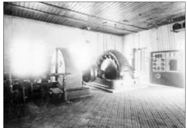
Abb. 8: Turbinenraum des Kraftwerkes Rother Graben, ca. 1895 (KLA, BBU).
