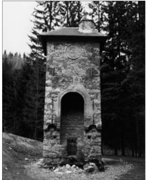
Abb. 5: Bleischmelzofen (Halbhochofen) in Feistritz ob Bleiburg (Ruttach-Schmelz) während der Restaurierung. Aufnahme: K. H. Kassl, 1998.
