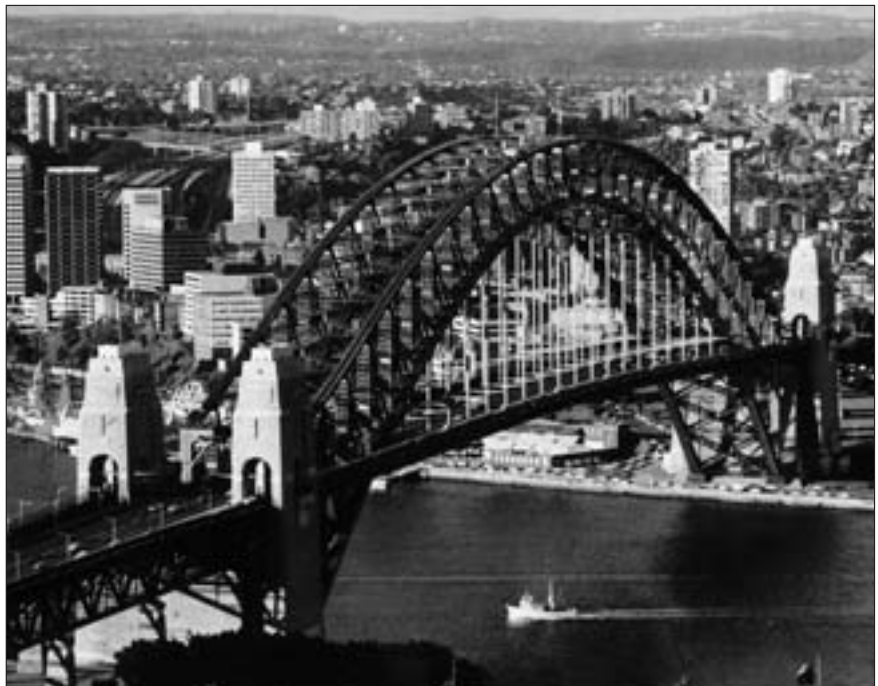
Abb. 1: Hafenbrücke in Sydney. Die Stahlkonstruktion wurde mit 130 Tonnen Rostschutzlack beschichtet. Der Anteil von Waldensteiner Eisenglimmer beträgt 20 %. Aufnahme: F. Prugger, 1992.
