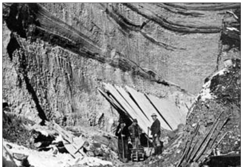
Abb. 14: Feigenstein Anna-Stollen, Sanierungsarbeiten nach dem Wasserausbruch 1955.
