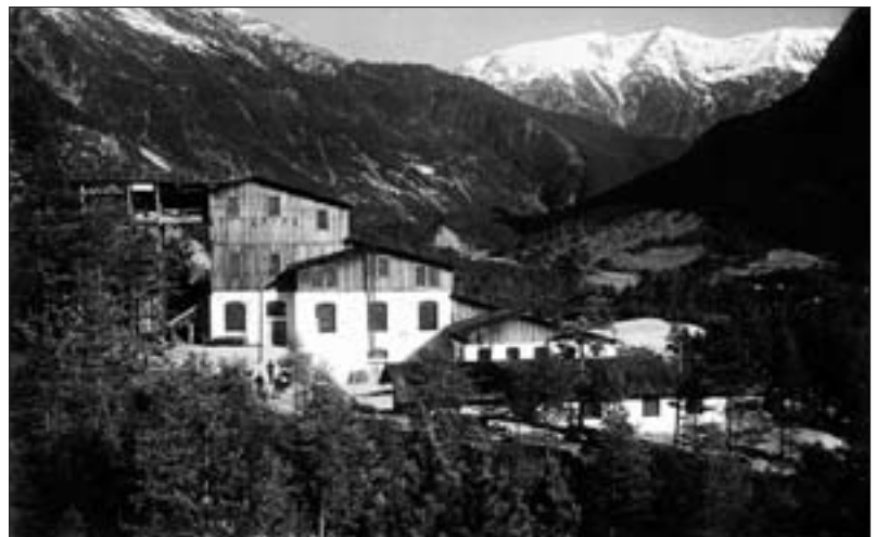
Abb. 6: Die Aufbereitung am Ausgang des Gafleintales während der Dulong'schen Betriebszeit.
