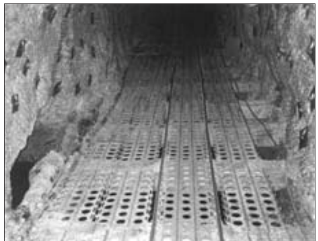
Abb. 2: Franz-Josef-Stollen, Laufwerk für Befahrung
