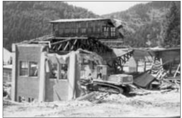
Abb. 8: Abbruch der Flotation Ost
