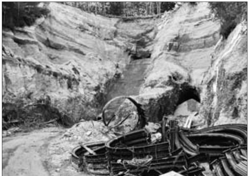
Abb. 15: Feigenstein Anna-Stollen, Beginn der Sanierungsarbeiten nach dem Wasserausbruch 1999, Archiv Simon.
