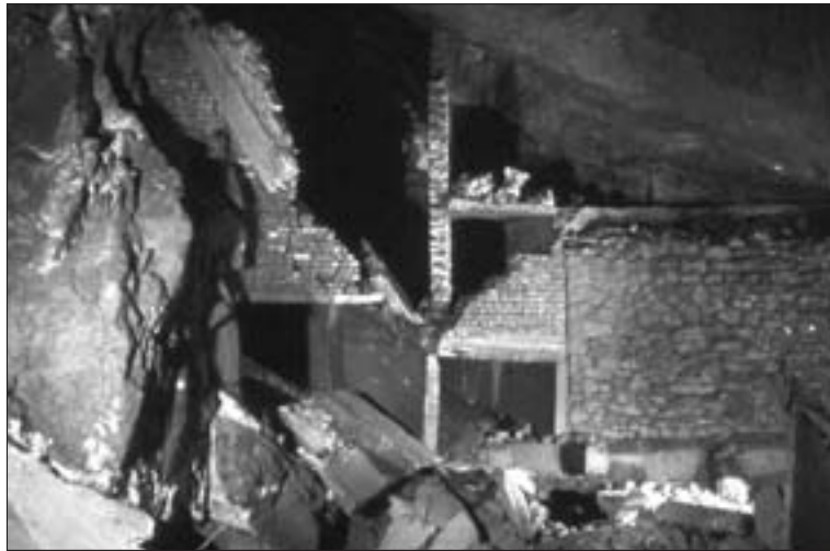
Abb. 10: Während des 2. Weltkrieges wurden die Messerschmittwerke in einen Teil der Auserzungen im Neuen Krummörterrevier verlagert. Im Bild der Nordrand der „Nordhalle“ mit Resten der Lüftungskanäle. Diese bis z. T. fünfstöckige untertägige Flugzeugfabrik wurde nach Kriegsende von den Alliierten gesprengt.
