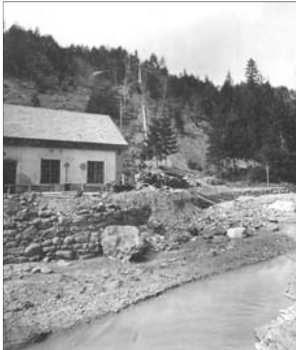
Abb. 7: Primärstation im Rothen Graben, ca. 1895 (KLA, BBU).
