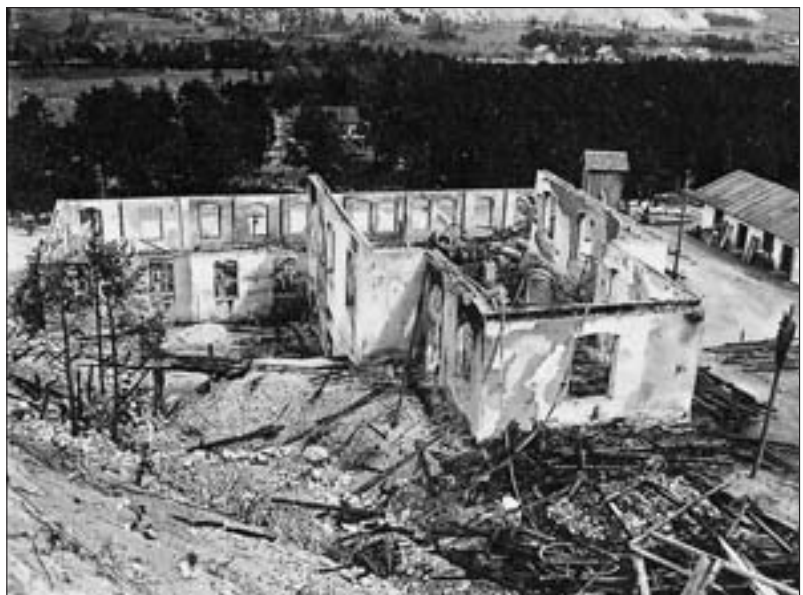
Abb. 9: Die Aufbereitung nach dem Brand 1928.
