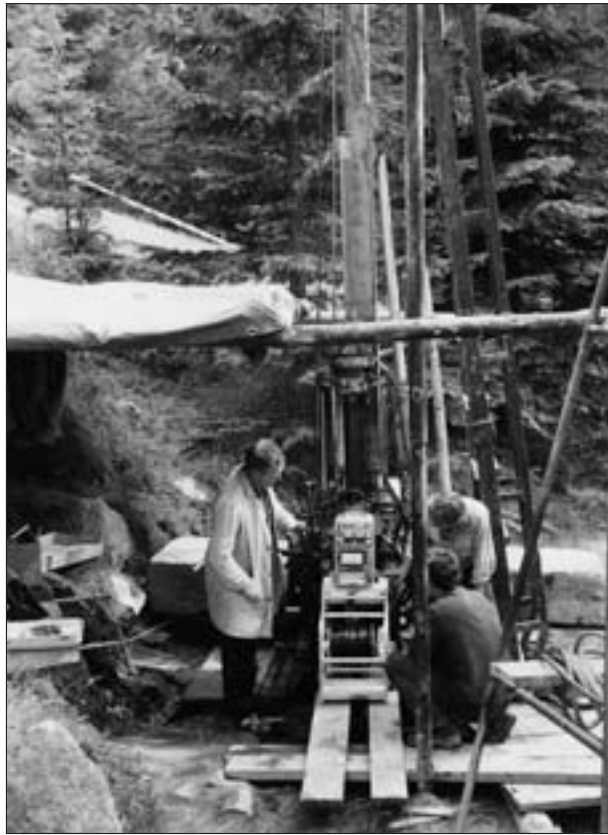
Abb. 4: Erkundungsbohrung kombiniert mit geophysikalischer Bohrlochvermessung. Aufnahme: F. Prugger, 1985.
