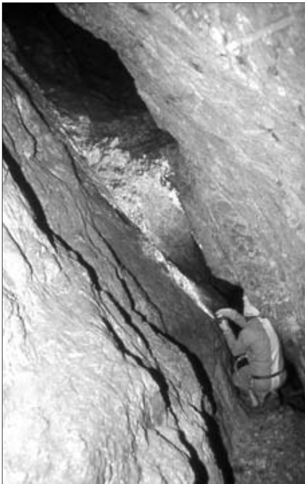
Abb.4: Noch in Originalbreite erhaltener Abbau an einem der Rabergänge im Alten Schachttrevier des Sigmund-Erbstollens ca. 5 m unter Ebensohle (derzeit abgesoffen). Viele dieser Abbaue wurden nach 1670 geweitet (Übergang zur Schiefttechnik). Im Bild Silvester Haberfellner.
