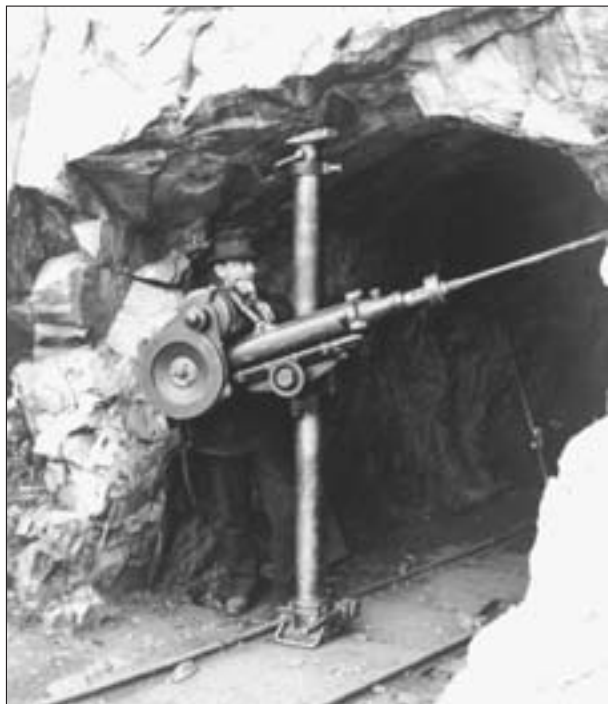
Abb. 10: Die Soleonid-Bohrmaschine, um 1895 (KLA, BBU).
