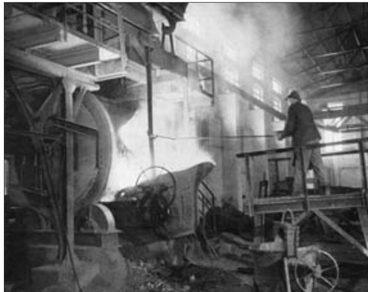
Abb. 6: Arbeit am Trommelkonverter in der Kupferhütte in Brixlegg, um 1960. Aus: 500 Jahre Kupferhütte Brixlegg 1463-1963. Brixlegg 1963.
