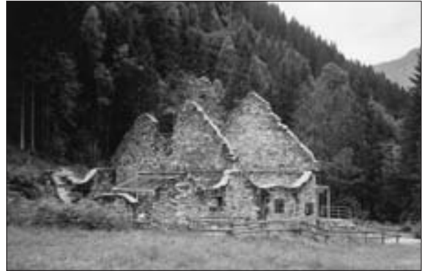
Abb. 9: Krummofen zur Herstellung von Nickelspeise, erbaut um 1840, heute Nickelmuseum. Im rechten Bildteil, teilweise vom Zaun verdeckt, das Röstbett. Hopfriesen (Foto: A. Weiß, 2005).
