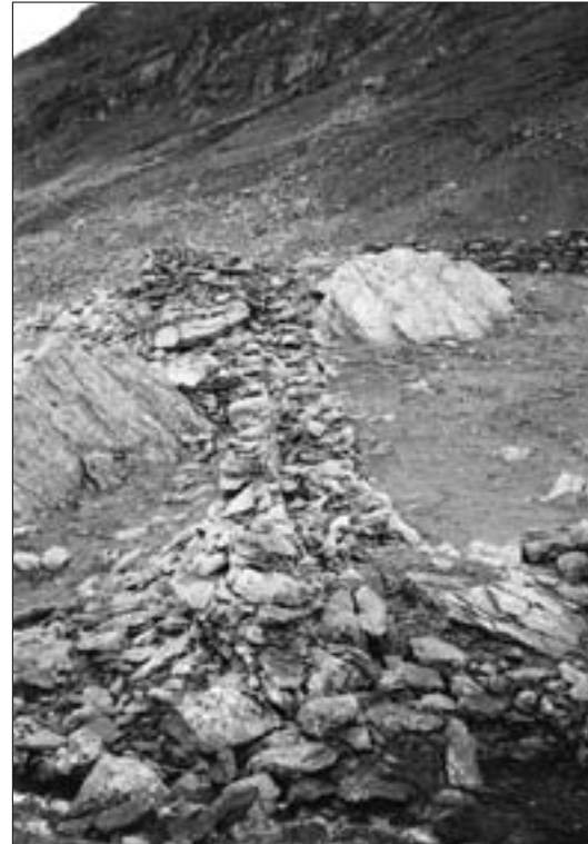
Abb. 12: Ruine eines Berghauses im Vettertkar. Ein Schneekragen sicherte den Zugang zu einer Quelle (Foto: A. Weiß, 2000).
