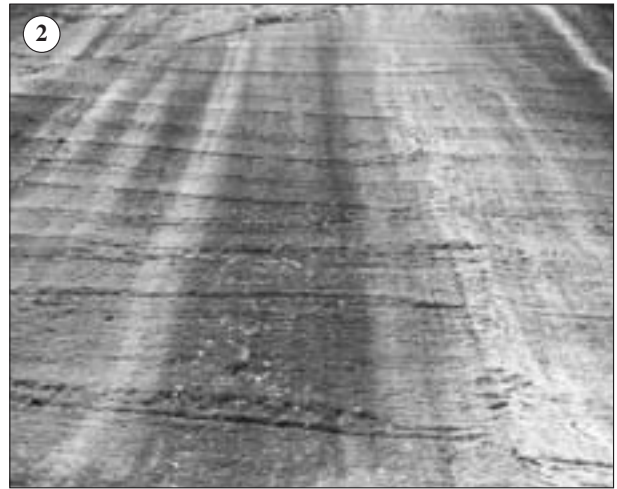
Abb. 27: Bearbeitete Wände. Schramrillen. Bild 1 = Wand 1, Bild 2 = oberer Teil der Wand 3. Foto R. Konopasek, Oktober 2004.
