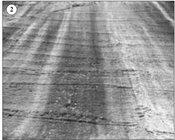
Abb. 27: Bearbeitete Wände. Schramrillen. Bild 1 = Wand 1, Bild 2 = oberer Teil der Wand 3. Foto R. Konopasek, Oktober 2004.
