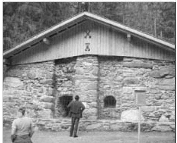
Abb. 18: Der Walchener Schwefelofen (Röststadel) nach Abschluss der Instandsetzungsarbeiten im Frühjahr 2004 als Teil des Öblerner Kupferweges. Aufnahme: G. Dembski, Oktober 2004.
