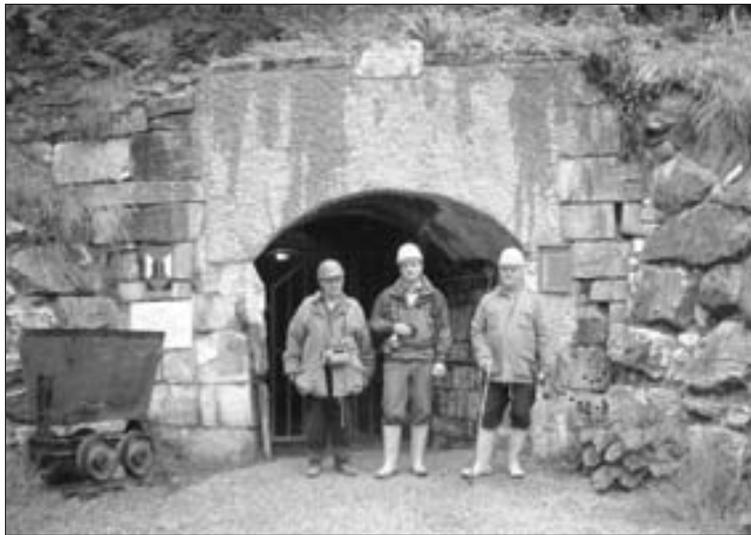
**Abb. 7:** Das wiedererrichtete Portal des Thaddäusstollens nach erfolgter Sicherheits- und Sanierungstätigkeit (Foto Karl Herbert Kassl 04. 07. 2003).
