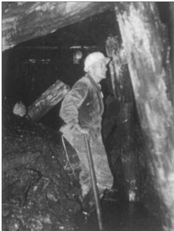
Abb. 4: Ausgeräumter Verbruch im Thaddäusstollen bei ca. Stollenmeter 100 (Aufnahmen Dr. Unger, Sept. 1967, Archiv Hans Jörg Köstler).
