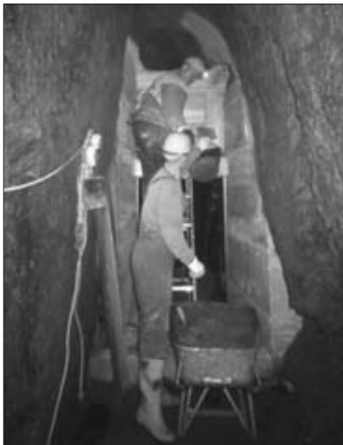
Abb. 11: Bauarbeiten an der Dämmtüre durch den Bergbauverein Öblarn (Foto: Bergbauverein Öblarn, 2003).
