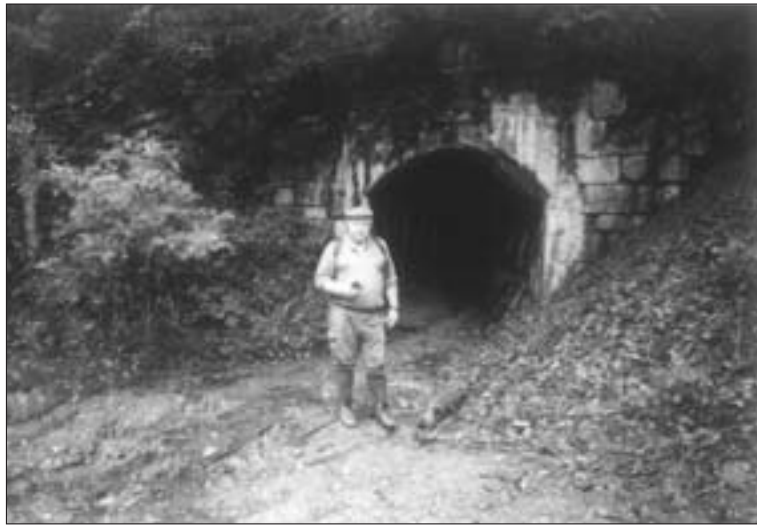
Abb. 6: Das Portal des Thaddäusstollens 1997 vor der Instandsetzung (Foto Karl Herbert Kassl 26. 07. 1997).
