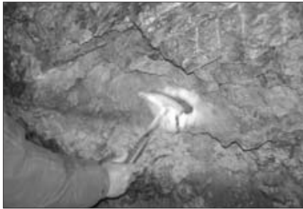
Abb. 8: Im Bereich der einzubauenden Dämmtüre steht ein phyllitischer Schiefer an, der Stollen weist bis ca. 1 m Höhe (Bereich des Hammers) aufgrund des jahrzehntelangen Wasserstaus eine orange-rote Färbung auf (Foto Karl Herbert Kassl 04. 07. 2003).
