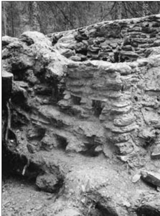
Abb. 16: Übereinander angeordnete Schwefelkanäle des Walchener Schwefelofens. Aufnahme: H. J. Köstler, Oktober 2003.
