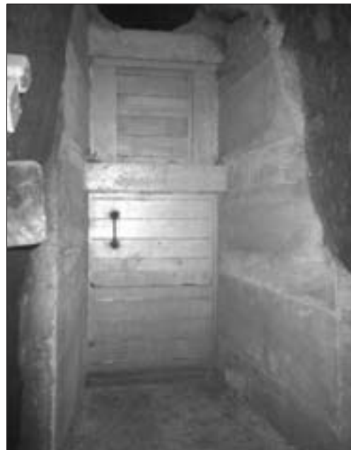
Abb. 12: Die fertige Dämmtüre, bergseitig gesehen, rechts die zubetonierte Nische (Foto: Bergbauverein Öblarn, 2003).
