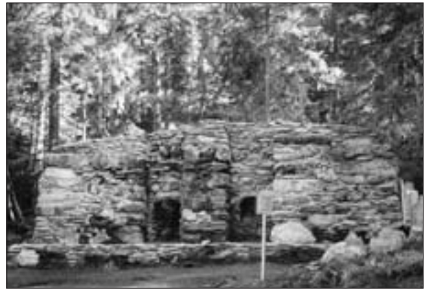
Abb. 17: Straßenseitige Front des Walchener Schwefelofens. Aufnahme: H. J. Köstler, September 2003.
