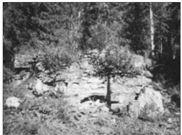
Abb. 14: Reste des Walchener Schwefelofens, verfallene und teils überwachsene straßenseitige Front (Schmalseite) im Sommer 2002. Aufnahme: G. Dembski.
