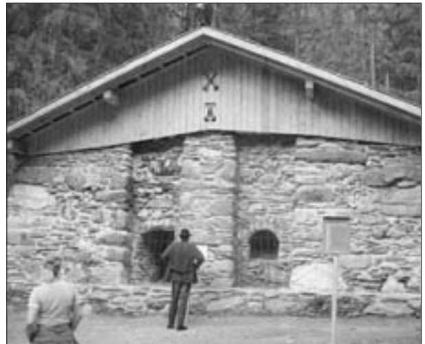
Abb. 18: Der Walchener Schwefelofen (Röststadel) nach Abschluss der Instandsetzungsarbeiten im Frühjahr 2004 als Teil des Öblarner Kupferweges. Aufnahme: G. Dembski, Oktober 2004.
