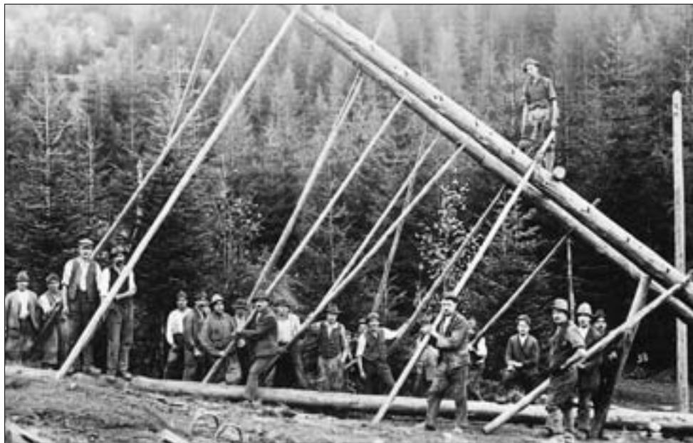
*Abb. 13: Aufstellen einer neuen Seilbahnstütze zwischen dem Kohlenbergbau Unterlaussa (Grubenfeld „Josef“) und dem Ort Unterlaussa-Dörfl. Unbezeichnete und undatierte (Jahresmitte 1934). Aufnahme: Bildarchiv H. J. Köstler, Fohnsdorf.*
