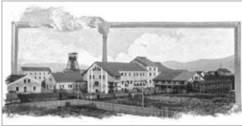
Wodzicki-Schacht und Aufbereitung (Fohnsdorf).
