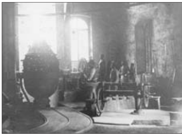
Abb. 1: Bessemerstahlwerk in Turrach um 1870 (?); links Bessemerkonverter (Birne), rechts Gießanlage. Die Fotografie trägt auf der Rückseite die Aufschrift „Das Innere der Bessemerhütte beim Lichte der Bessemerflamme“ und befindet sich im Eisensaal des Schlosses Murau.
