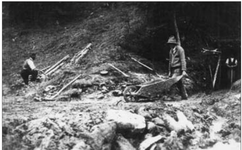
Abb. 15: Stollen II (Knappenstubenstollen) des „Schurfbaues Gössnitz, Heiligenblut“, Oktober 1933. Links: Zurichten von Grubenholz, rechts: Stollenmundloch. Aufnahme im Fahrbuch Gößnitz in der ehemaligen Berghauptmannschaft Klagenfurt.
