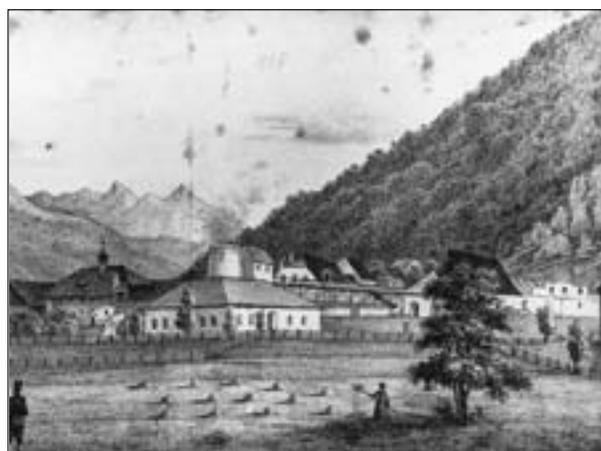
*Abb. 4: Eisenwerk „Annahütte“ in Raggabach bei Flattach. Links: Verweserhaus (?), links der Bildmitte: Hüttengebäude mit Hochofen und Gichturm; um 1850 (?). Unsignierte und undatierte Lithographie im Landesmuseum für Kärnten, Klagenfurt.*
