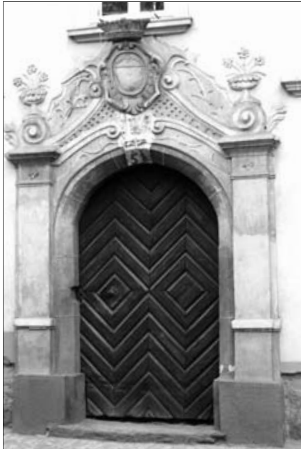
Abb. 7: Portal des Verweserhauses der Porcia (Foto: W. Deuer).
