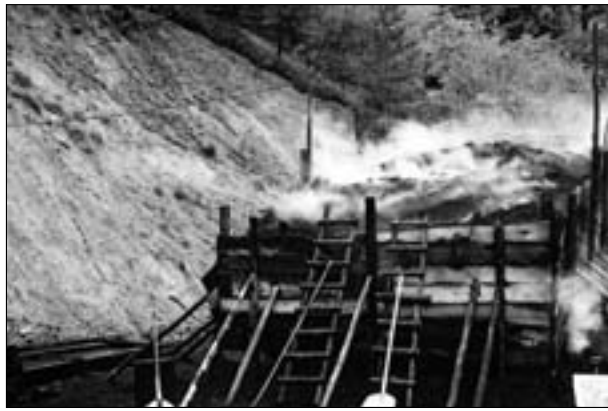
Abb. 1: „Liegendes Werk“ in Rohr im Gebirge an der NÖ-Köhlerstraße. Aufnahme: B. Hable, Mai 2004.
