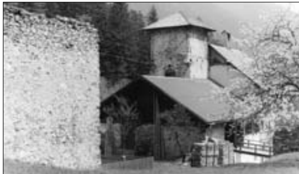
Abb. 15: Hochofen mit Hüttengebäude (rechts) und Kohlbarren (links) in Laas am Gailbergsattel. Aufnahme: H. J. Köstler, Mai 1987.
