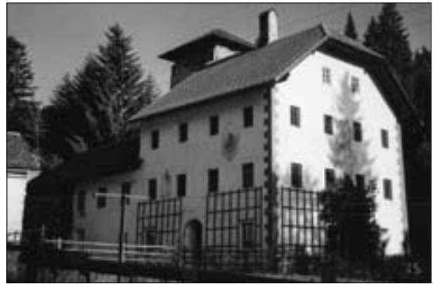
Abb. 17: Verwaltungs- und Personalhaus beim Hochofen in Laas. Aufnahme: H. J. Köstler, September 2003.
