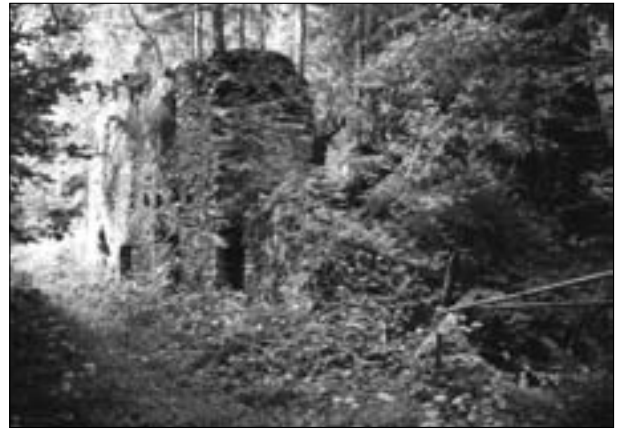
Abb. 11: Mauern des Berghauses beim ehemaligen Quecksilberbergbau Buchholzgraben bei Stockenboi (Foto K. H. Kassl, Juni 1994).
