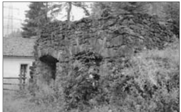
Abb. 18: Erzröstanlage (zwei aneinander gebaute „Röststadel“) beim Hochofen in Laas – soweit bekannt, die einzige erhaltene Röstanlage dieser Art in Österreich. Aufnahme: J. van Iken, Juli 2003.
