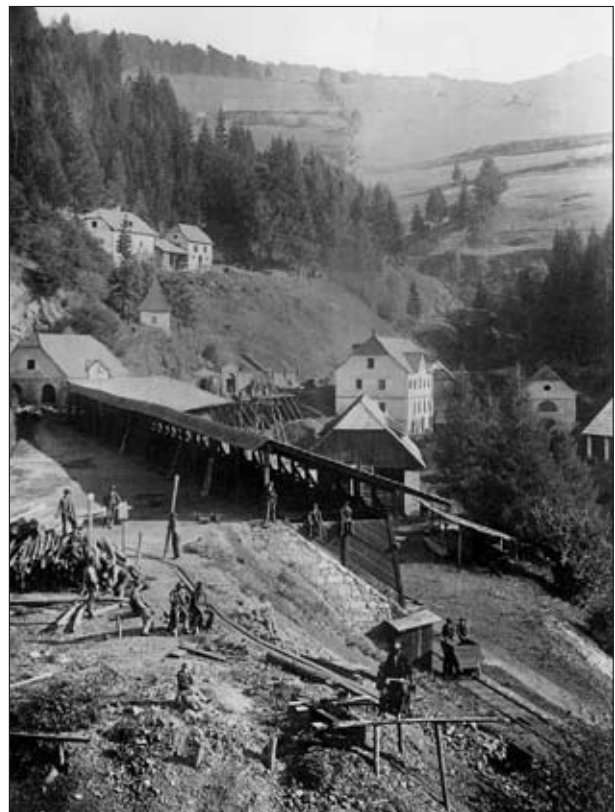
Abb. 9: Hüttenberger Erzberg, Revier Lölling. Gebäude und Erzförderanlagen beim Löllinger Erbstopfen um 1890. Links oben: Georg-Stollen und Pulverturm; rechts der Bildmitte: Grubenhaus, zwischen diesem und dem Pulverturm die beiden Mundlöcher des Erbstopfens (vgl. Abb. 10); im Vordergrund: Erzfüllkästen und Bahn zum Eugen-Bremsberg. Aufnahme im Besitz von H. J. Köstler (Nachlass W. Schuster).
