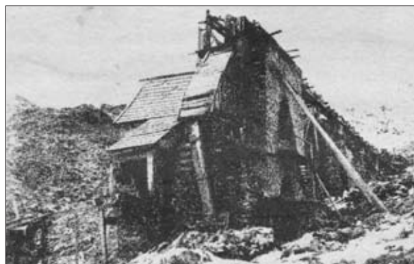
Abb. 5: Rauriser Goldberg. Kopfstation (Radhaus mit Kehrrad) des Schrägaufzuges bzw. Bremsberges zwischen Kolm-Saigurn und dem untersten Bereich des Bergbaugebietes; 1881. Fotoreproduktion im Besitz von H. J. Köstler.
