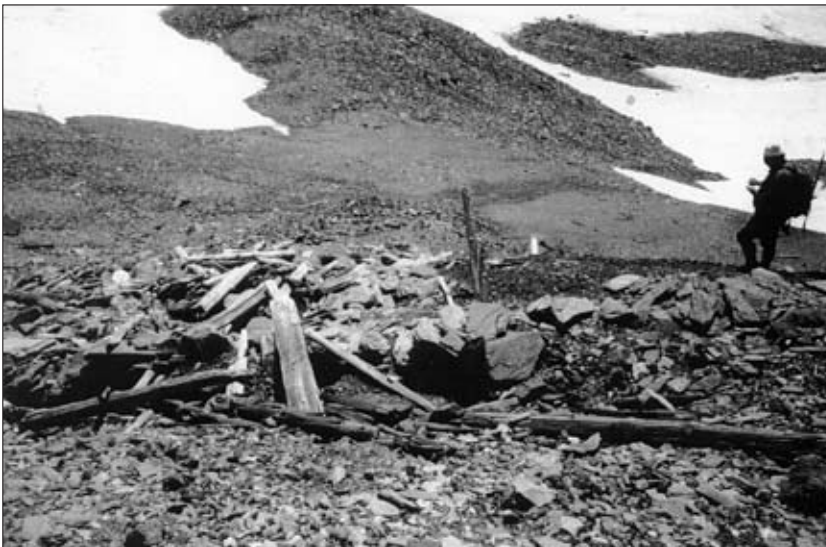
Abb. 9: Bauholz und Naturbausteine bei dem als (ehemalige) Scheidstube bezeichneten Gebäuderest. Aufnahme: K. H. Kassl, August 1997.
