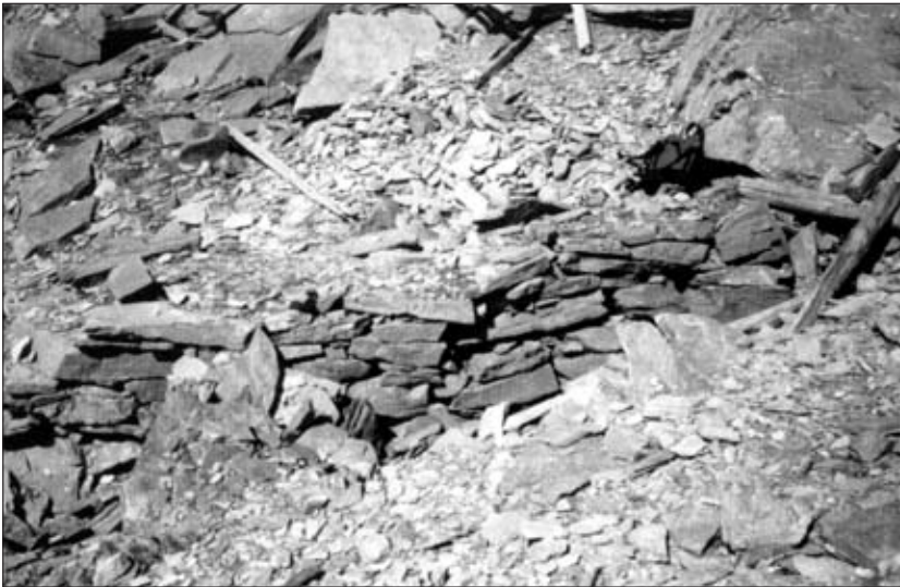
Abb. 4: Trockenmauerwerk des Schneekragens beim Andre-Stollen. Aufnahme: H. J. Köstler, August 1997.
