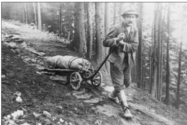
Abb. 7: Sackzug (Erzförderung mit sog. Halbwagen) auf dem Steirischen Erzberg (Innerberger Revier) von 1564 bis ungefähr 1810. Gestellte Aufnahme um 1925. Aufnahme im Besitz von H. J. Köstler (Nachlass W. Schuster).
