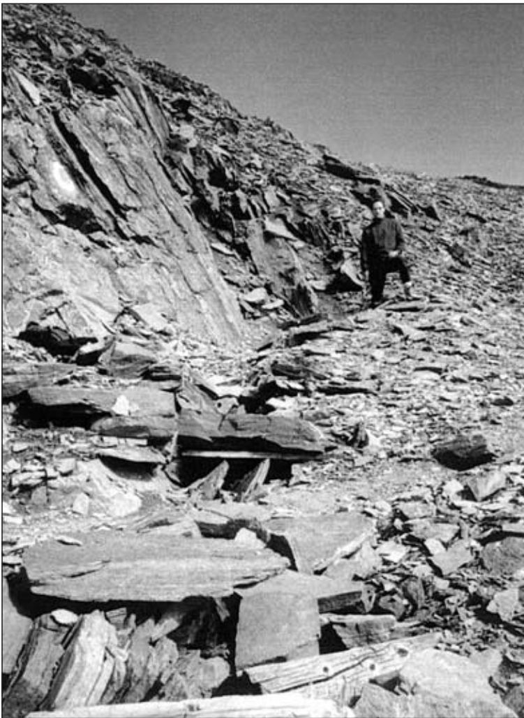
Abb. 3: Schneekragen (ursprünglich gedeckter Gang) zwischen Knappenhaus und Mundloch des Andre-Stollens( vgl. Abb. 4 und 7), ca. 2.860 m über NN. Vorne Bauholz des Knappenhauses, unmittelbar dahinter Zentralalpenweg 02, der den Schneekragen überquert. Aufnahme: H. J. Köstler, August 1997.
