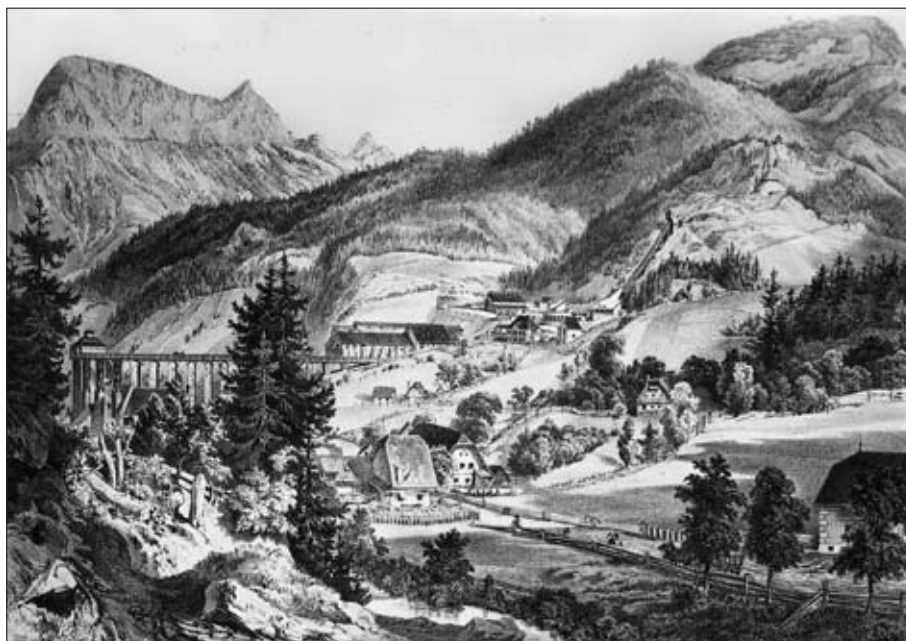
Abb. 1: Steirischer Erzberg um 1860, Hauptfördersystem auf der Innerberger Seite. Rechts: Erzberg, Erzrutsche und Gebäude beim Sybold-Stollen (rechts der Bildmitte); links der Bildmitte: Sybold-Halde (Erzmagazin); links: Erzbahn auf Steinpfeilern zum Kaiser-Franz-Hochofen. Fotoreproduktion im Besitz von H. J. Köstler (Nachlass W. Schuster).
