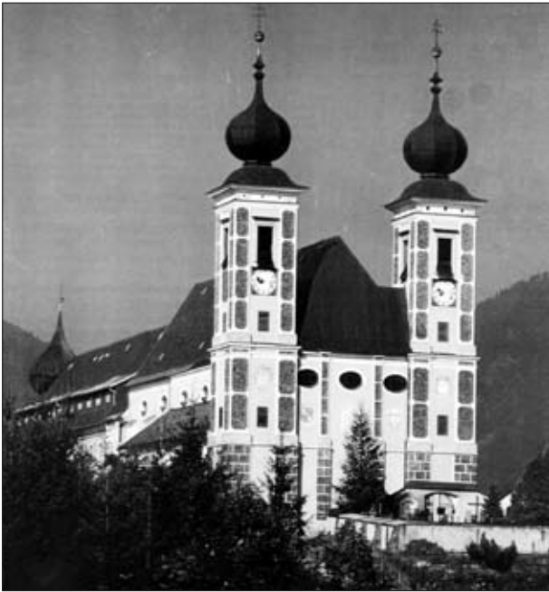
Abb. 4: Wallfahrtskirche Frauenberg bei Admont, die Kupferschlacke wurde als Dekorbaustoff an den Außenwänden der Türme verwendet (18).
