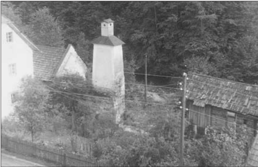
Abb. 5: Esskobel eines zum Nagelschmiedfeuer umgebauten Frischherdes im ehemaligen Hammerwerk in Lainbach bei Hieflau. Aufnahme: H. J. Köstler, August 1964.
