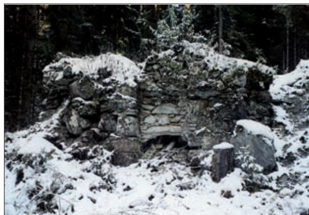
Abb. 1: Erzröstanlage („Schwefelofen“) in der Walchen bei Öblarn; linker Schwefelfang in der straßenseitigen Frontmauer erkennbar (Vgl. Abb. 2). Aufnahme: H. J. Köstler, Nov. 2001.
