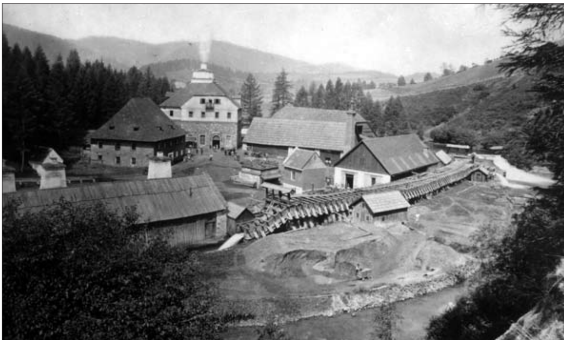
Abb. 5: Neupersches Eisenwerk („Schmelze“) in Unterzeiring um 1880 (?) (siehe Abb. 4). Der „Franzisi“-Hochofen wurde 1850/52 von Franz Xaver Neuper als Ersatz für den „Leopold“-Hochofen erbaut und schmolz bis 1886. Undatierte Aufnahme in Privatbesitz.
