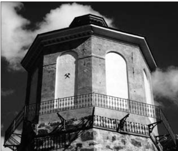
Abb. 49: Rauchhaube mit Fluchtbalkon des Hochofens in Bundschuh. Vor allem beim Begichten entströmte dem Hochofen kohlenmonoxid- und kohlendioxidhaltiges Gas (Gichtgas), das alle Mitarbeiter auf der Gicht in Mitleidenschaft zog; zur „Erholung“ und auch zur Flucht vor kleineren Explosionen diente der bei jedem älteren Hochofen vorhandene Fluchtbalkon. Aufnahme: H. J. Köstler, Juli
