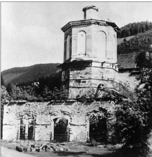
Abb. 31: Hochofen mit Resten des Hüttengebäudes der „Franzeshütte“ in Bundschuh im Juli 1963. Aufnahme: Schwarzenbergische Archive Murau
