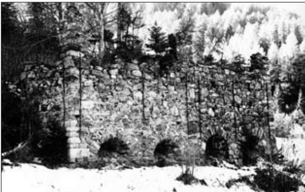
Abb. 40: Vorder- bzw. Nordfront der Erzröstöfen in Bundschuh; je zwei Gewölbe für das Abziehen des Rösterzes in der älteren (um 1840) und der jüngeren Anlage (1862/64). Aufnahme: H. J. Köstler, Dezember 1978
