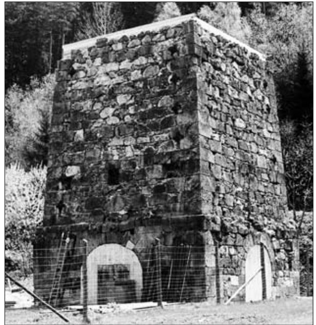
Abb. 4: Ofenstock des Hochofens in Aschbach nahe Mariazell (heute mit pyramidenförmigem Dach). Aufnahme: H. J. Köstler, Mai 1995
