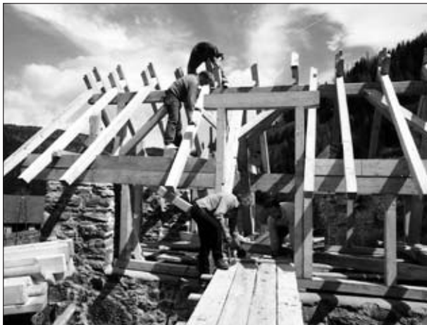
Abb. 44: Erzröstanlage (Südseite) in Bundschuh. Aufstellen des Dachstuhles über den Röstlöfen. Aufnahme: J. Heiß, 1991
