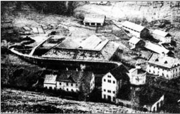
Abb. 23: Hochofenanlage „Franzeshütte“ in Bundschuh um 1885/90 (?). Reproduktion einer Ansichtskarte im Besitz von H. J. Köstler. Links hinten: Erzröstanlage und Köhlerei (?); Bildmitte: Kohlbarren; vorne: Hegerhaus (früher Knap-pengasthaus) sowie Gebläsehaus und Hüttengebäude mit Hochofen; rechts vorne: Forsthaus (früher Verweshaus); rechts hinten: u. a. Arbeiterwohnhaus.
