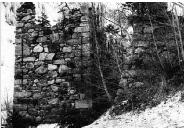
Abb. 41: Westseite der Erzröstanlage in Bundschuh. Rechts: Rampe (Stützmauer) für die Zufuhr von Roherz und Holzkohle; links: Erzröstöfen. Aufnahme: H. J. Köstler, Dezember 1978
