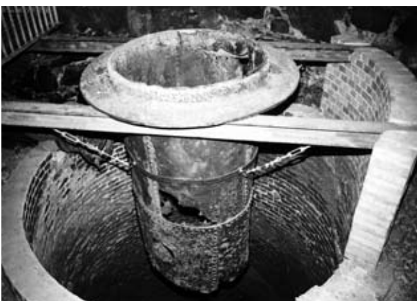
Abb. 33: Gichtzylinder des Hochofens in der „Franzeshütte“ in Bundschuh. Aufnahme: J. Heiß, August 2000 Die Begichtung des Hochofens erfolgte durch den Gichtzylinder, der auch das fast verlustfreie Ableiten des Gichtgases durch eine eigene Rohrleitung ermöglichte, vgl. Abb. 19.
