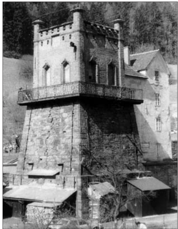
Abb. 7: Hochofen in St. Gertraud im Lavanttal (Kärnten); rechts hinten: Aufzugsgebäude mit Möllerboden. Aufnahme: H. J. Köstler, April 1987
