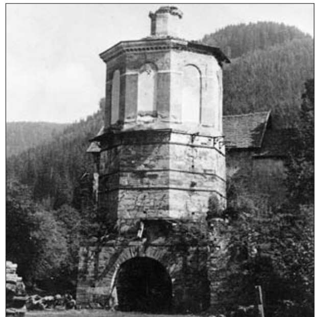
Abb. 32: Hochofen der „Franzeshütte“ in Bundschuh im Juli 1967. Aus Wehdorn, Die Baudenkmäler ...wie Anm. (43)
