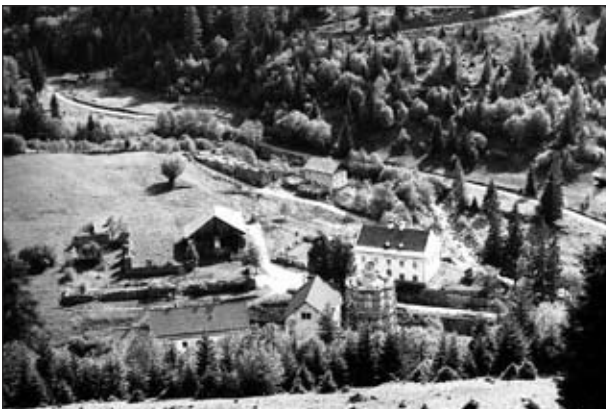
Abb. 34: Restaurierung des eingerüsteten Hochofens der „Franzeshütte“ in Bundschuh 1976. Aufnahme: Schwar- zenbergische Archive Murau
