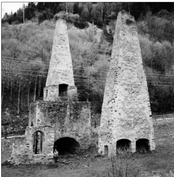
Abb. 10: Hochofen (Flossofen, links) und Frischfeuer (rechts) in Kendlbruck (Lungau). Aufnahme: H. J. Köstler, Mai 1998
