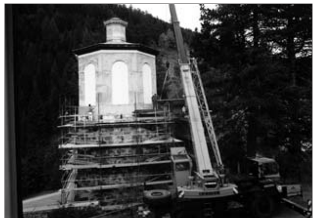
Abb. 47: Restaurierung des Hochofens der „Franzeshütte“ in Bundschuh; „Großbaustelle“ im Rahmen der Generalsanierung 1994. Aufnahme: J. Heiß
