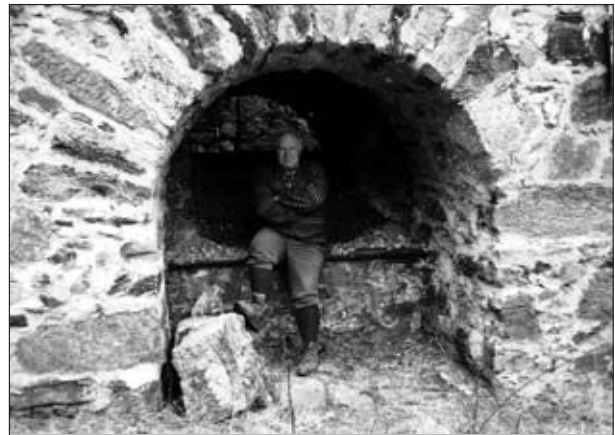
Abb. 46: Gewölbe für das Abziehen des Rösterzes (westlichster Ofen), vgl. Abb. 42 und 43. Aufnahme: K. H. Kassl, Mai 1998
