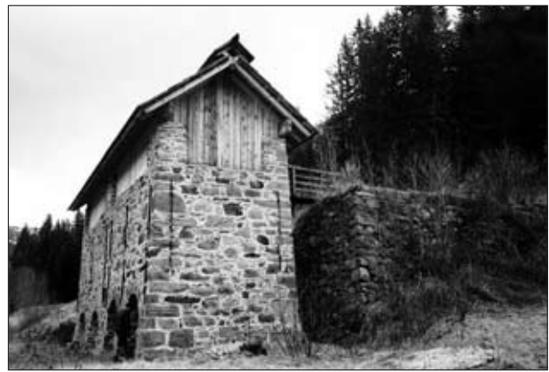
Abb. 45: Erzröstanlage in Bundschuh. Rechts: Rampe für die Zufuhr von Roherz und Holzkohle; links: überdachte Röstlöfen; dazwischen Gichtsteg. Aufnahme: H. J. Köstler, Mai 1998
