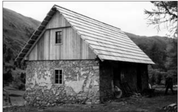
Abb. 9: Das 1996 wiedererrichtete Knappenhaus (Foto H. J. Köstler, 1997).
