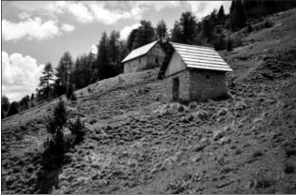
Abb. 11: Der mit Dach versehene Pulverturm mit dem Knappenhaus im Hintergrund, Blick nach Süden (Foto H. J. Köstler, 1997).
