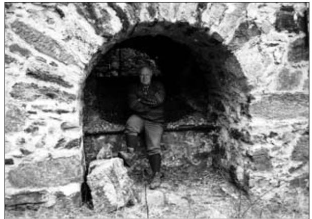
Abb. 46: Gewölbe für das Abziehen des Rösterzes (westlichster Ofen), vgl. Abb. 42 und 43. Aufnahme: K. H. Kassl, Mai 1998
