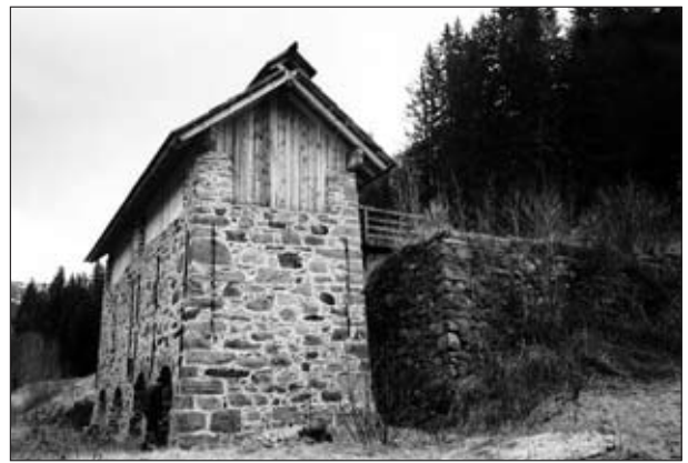
Abb. 45: Erzröstanlage in Bundschuh. Rechts: Rampe für die Zufuhr von Roherz und Holzkohle; links: überdachte Röstöfen; dazwischen Gichtsteg. Aufnahme: H. J. Köstler, Mai 1998
