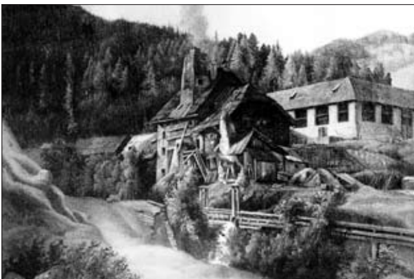
Abb. 13: Hochofenanlage (Flossofen) in Bundschuh, Ofen und Hüttengebäude 1807 erbaut; Vorläufer der späteren „Franzeshütte“. Bildmitte: Hochofen mit Hüttengebäude, davor Schmiede, rechts: Kohlbarren, links: Feldbach. Vgl. Abb. 12 und 15. Fotoreproduktion eines undatierten Gemäldes im Eisensaal des Fürst Schwarzenbergischen Schlosses in Murau
