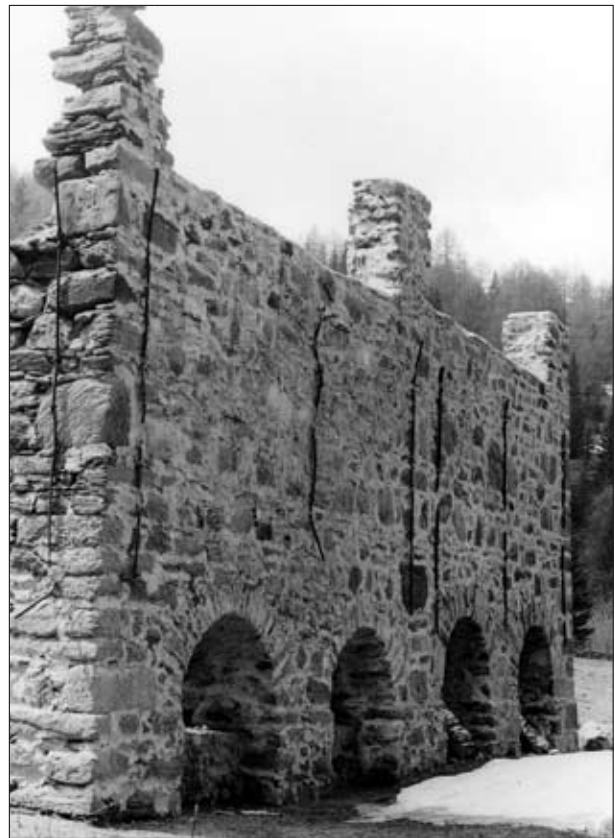
Abb. 42: Vorder- bzw. Nordfront der Erzröstanlage in Bundschuh, vgl. Abb. 40. Aufnahme: H. J. Köstler, Mai 1987
