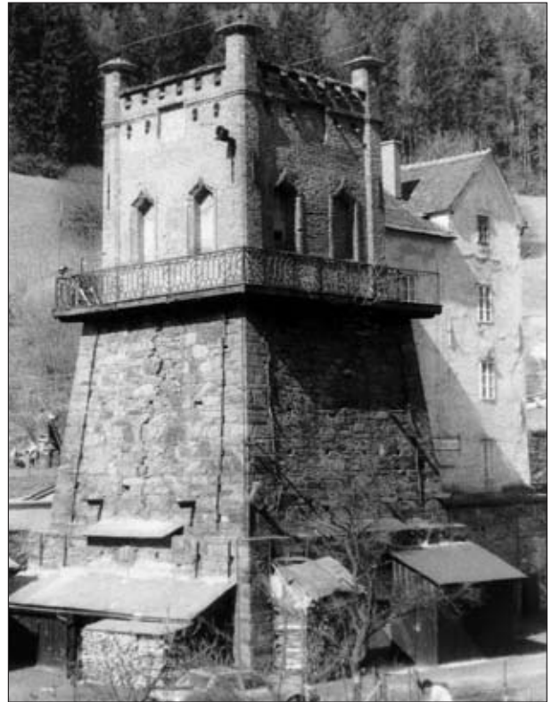
Abb. 7: Hochofen in St. Gertraud im Lavanttal (Kärnten); rechts hinten: Aufzugsgebäude mit Möllerboden. Aufnahme: H. J. Köstler, April 1987
