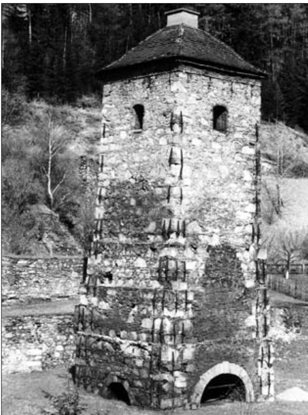
Abb. 3: Hochofen des Radwerks X in Vordernberg; rechts unten: Abstichgewölbe. Aufnahme: H. J. Köstler, Juli 1994
