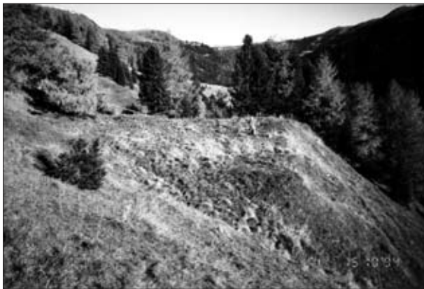
Abb. 7: Die bewachsene Halde des Kammelstollens, das Mundloch (links im Bild) ist inzwischen vollständig verbrochen, Blick nach Norden (Foto K. H. Kassl, 1994).
