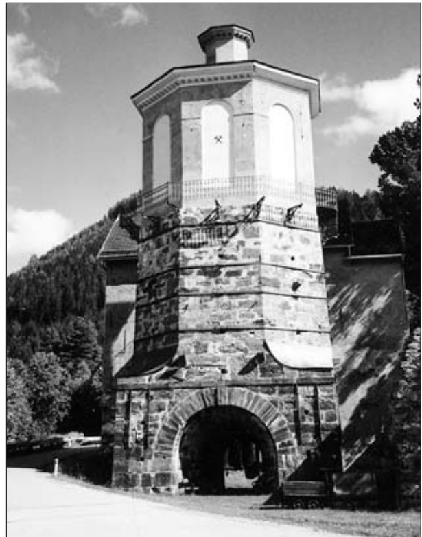
Abb. 1: Hochofenwerk „Franzenshütte“ in Bundschuh, seit 1984 Hochofen-Museum; Hochofen und dahinter Gebläsehaus mit Museumsräumen (Hüttengebäude nicht mehr vorhanden). Aufnahme: H. J. Köstler, Juli 2003
