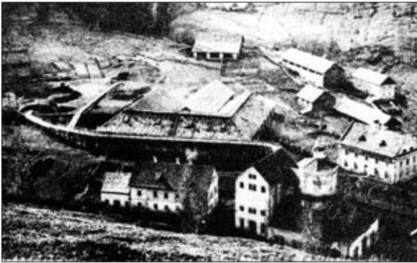
Abb. 23: Hochofenanlage „Franzeshütte“ in Bundschuh um 1885/90 (?). Reproduktion einer Ansichtskarte im Besitz von H. J. Köstler. Links hinten: Erzröstanlage und Köhlerei (?); Bildmitte: Kohlbarren; vorne: Hegerhaus (früher Knap-pengasthaus) sowie Gebläsehaus und Hüttengebäude mit Hochofen; rechts vorne: Forsthaus (früher Verweshaus); rechts hinten: u. a. Arbeiterwohnhaus.
