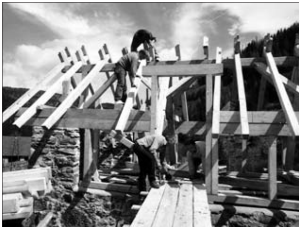
Abb. 44: Erzröstanlage (Südseite) in Bundschuh. Aufstellen des Dachstuhles über den Röstöfen. Aufnahme: J. Heiß, 1991
