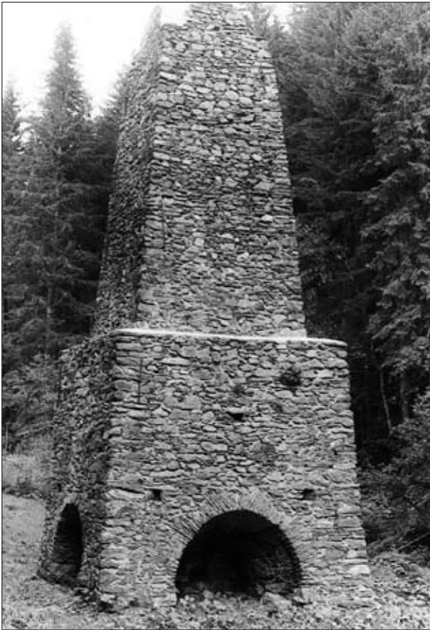
Abb. 5: Fuchsflossofen in Schottenau (Mosinzer Graben) bei Hüttenberg; vorne: Form- (Blas-) Gewölbe, links Abstichgewölbe. Aufnahme: H. J. Köstler, Juli 1994
