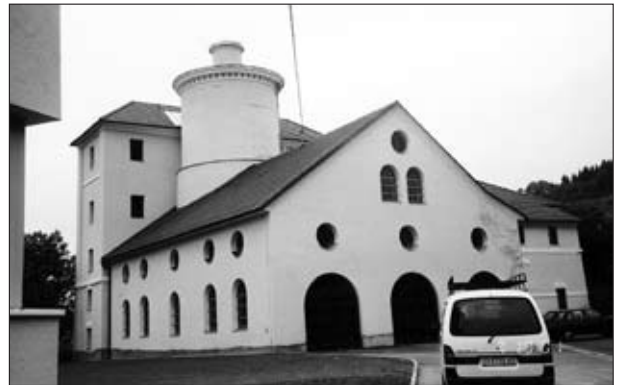
Abb. 8: Hochofenwerk in Olsa bei Friesach; links: Aufzugsgebäude und Hochofen, Mitte: Hüttengebäude. Aufnahme: H. J. Köstler, Juli 2001
