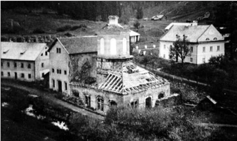
Abb. 30: Hochofenanlage „Franzenshütte“ in Bundschuh, um 1935. Aufnahme: W. Schuster
