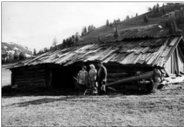
Abb. 1: Die sogenannte „Josefshütte“ - ein ehemaliger Heustadl - in Schönfeld in verfallenem Zustand im Jahr 1994, Foto: J. Heiß, Thomatal.
