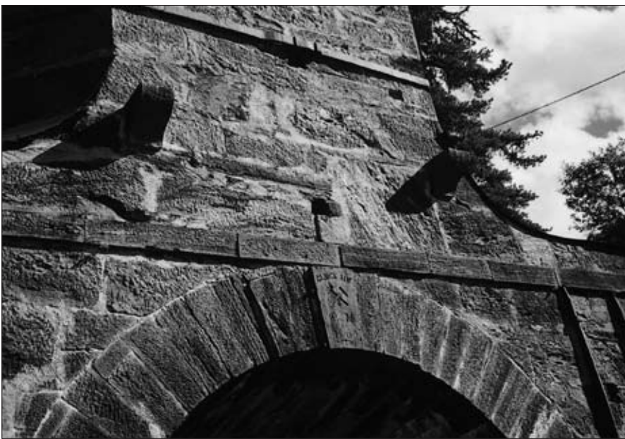
Abb. 51: Mittlerer Bereich des Hochofens in der Bundschuher „Franzenshütte“ (Abstichgewölbe). Aufnahme: H. J. Köstler, Juli 2003
