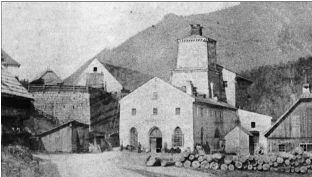
Abb. 12: Hochofenwerk in Liezen (am Pyhrnbach); Roheisenerzeugung 1854 – 1893. Undatierte Aufnahme (1880?) im Besitz von H. J. Köstler
