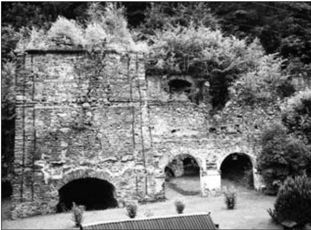
Abb. 6: Ofenstock des „Johanna“-Hochofens in Lölling bei Hüttenberg. Aufnahme: H. J. Köstler, Juni 2003
