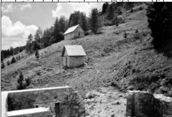
Abb. 12: Zwei sanierte Bergbauobjekte: Der Pulverturm (Mitte) und eine Knappenstube - die erste Dr. Mehrl-Hütte - in Schönfeld im Jahr 1997, Foto: J. Heiß, Thomatal.
