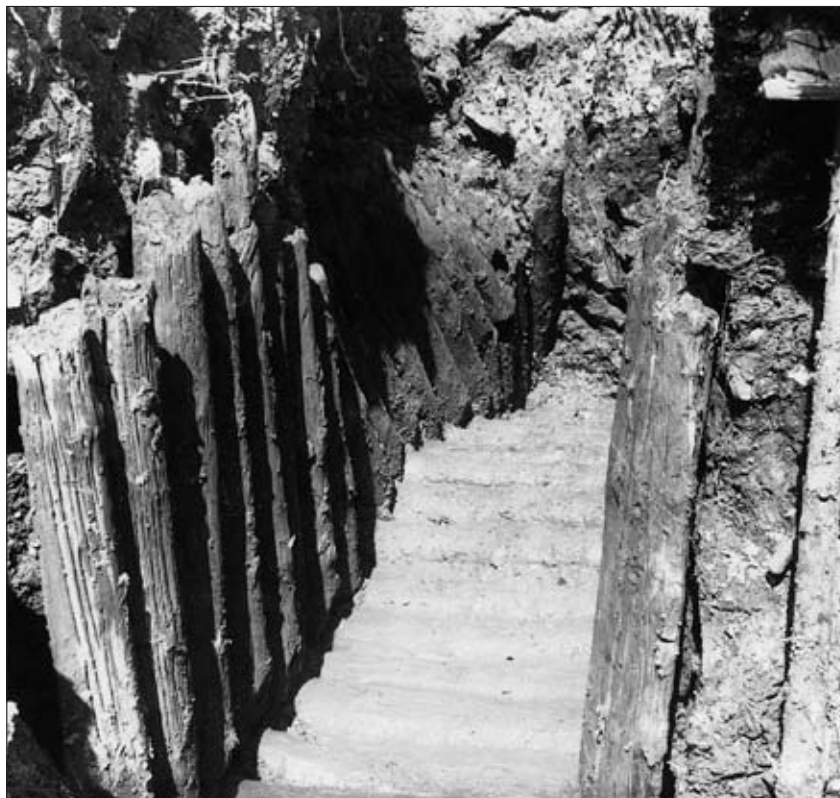
Abb. 4: Spätlatènezeitlicher Stollen, Dammwiese am Hallstätter Salzberg (Dammwiesengrabung 1937). Aufnahme: F. Morton/Museum Hallstatt.
