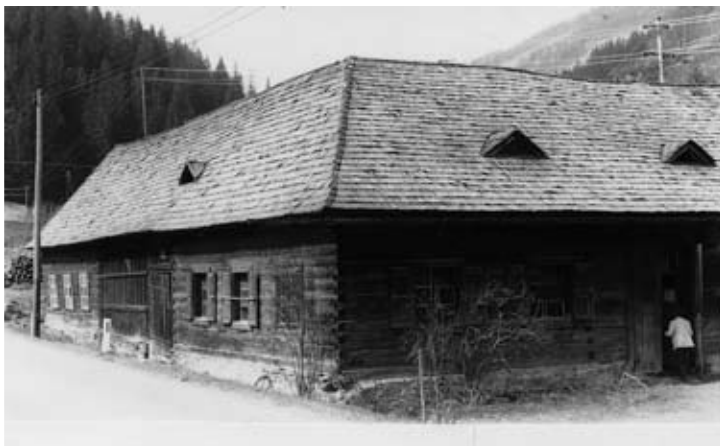
Abb. 11: Ehemalige Modelltischlerei in Turrach vor der Ausgestaltung zu einem Montanmuseum, Mai 1987. Aufnahme: H. J. Köstler
