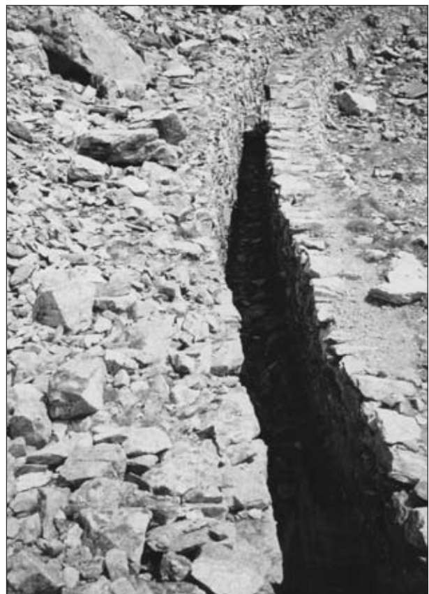
Abb. 9: Schneekragen im Bereich der Zinkwand; die Zugänge zu den Stollen wurden durch parallel laufende Trockenmauern, auf denen eine Decke aus Holzpfosten und Steinen lag, gegen Lawinen gesichert (Foto: A. Streicher, 2001).
