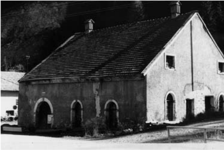
Abb. 9: Ehemaliges Bessemerstahlwerk (Bessemerhütte, später Gusschalle und Gussputzerei) in Turrach, Oktober 1969. Aufnahme: H. J. Köstler
