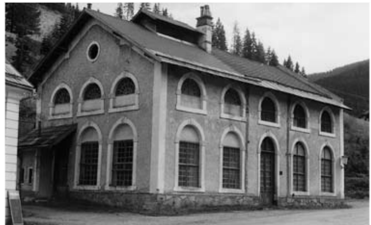
Abb. 10: Gusschalle des ehemaligen Eisenwerkes in Turrach, Juni 1985. Aufnahme: H. J. Köstler
