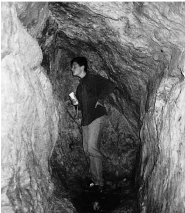
Abb. 7: Hirschaustollen am Weg zur Hirschaualm (Hallstatt), Ortsbrust im Dachsteinkalk. Vermutlich führte der Vortrieb entlang einer Störung zu einem asymmetrischen Stollenprofil (siehe Abb. 5). Aufnahme: Wirobal, 1995.
