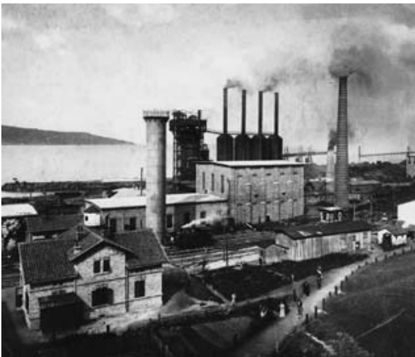
Abb. 5: Hochofenwerk der KIG in Servola bei Triest um 1900 (?); rechts im Hintergrund: Entladeanlagen für Koks. Der Bildbereich oben links zeigt die Hochofenanlage, die im Hintergrund rechts die Entladeanlagen für Koks darstellt. Die Hochofenanlage ist ein großer, zylindrischer Ofen, der von mehreren hohen Schloten umgeben ist. Die Entladeanlagen für Koks sind eine Reihe von kleineren, rechteckigen Gebäuden, die in einer Reihe angeordnet sind. Die gesamte Anlage ist in einem industriellen Umfeld mit weiteren Gebäuden und Strukturen zu sehen.
