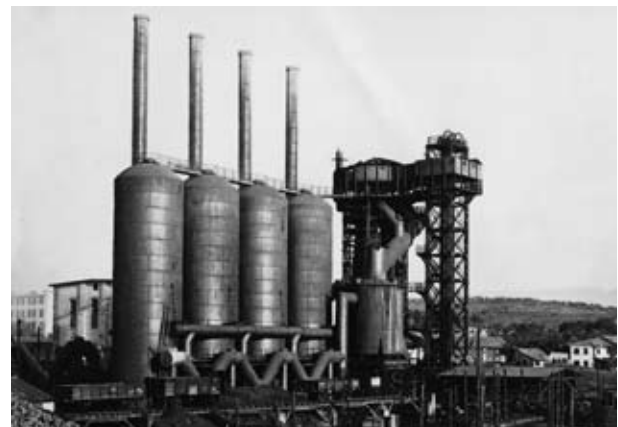
Abb. 4: Hochofenwerk der KIG in Servola bei Triest um 1900 (?); von links nach rechts: 4 Winderhitzer (System Cowper), dahinter Gebläsehaus, vor den Cowpern Windleitungen sowie Erz- und Koks waggons; Bildmitte: Hochofen (I) mit Gichteinrichtungen auf Stahlgittergerüst; vor dem Hochofen: Gichtgasreiniger (Entstaubung); unmittelbar rechts des Hochofens: Gichtturm mit Gichtaufzug (Stahlgittergerüst); Abb. 4 und Abb. 5 zeigen das augenscheinlich musterbildig orientierte und im April 1907 bzw. im August 1907 erbaute Hochofenwerk Servola um die Jahrhundertwende, also bald nach 1897, aber sicher vor Erbauung der ersten Koksöfen. Gute Erfahrungen mit dem Hochofen I veranlassten die KIG zum Bau weiterer zwei Öfen (II und III), die im April 1907 bzw. im
