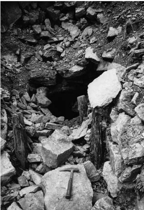
**Abb. 3:** Das Mundloch des Grasleitenstollens in der Großen Zirknitz mit Resten der Zimmerung (Aufn.: K. H. Kassl, Juli 1995). Waschgang
