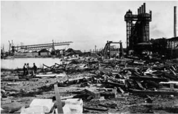
Abb. 2: Hochofenwerk der KIG in Servola bei Triest; einzige am Meer gelegene Eisenhütte in Alt-Österreich. Wahrscheinlich zur Jahresmitte 1897; im Hintergrund links Anlagen für die Entladung von Koks und Erzsängsprofile eine im Vergleich zur im 19. J. üblichen Donawitzer Hochofen I weitgehend andere, möglicherweise von amerikanischer Bauart beeinflusste Konstruktion des Ofens I in Servola.
