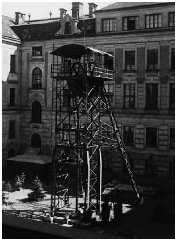
Abb 1: Fördergerüst einer Versuchsschachtanlage im Innenhof der Montanistischen Hochschule Leoben, 1931
