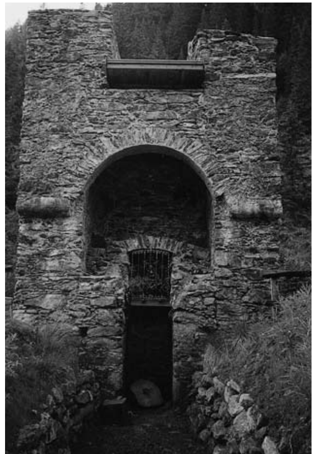
glanzschmelzen lassen auf Versuchsschmelzungen beim Bergbau des Schmelzofen in der Draßnitz bei Dellach im Drautal nach seinem Umbau zu einer „Touristenattraktion“ (Aufn.: K. H. Kassl, Juni 1996).
