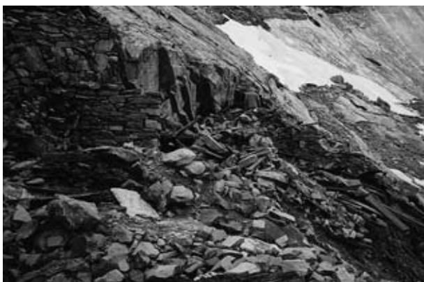
Abb. 1: Die Reste des Berghauses beim Annastollen auf der Goldzeche im Kleinen Fleißtal (Aufn.: K. H. Kassl, August 1994).
