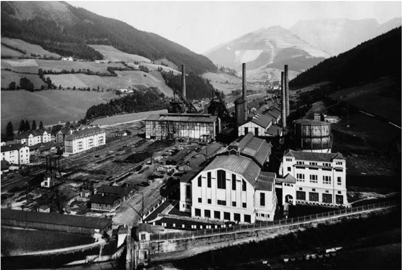
Abb. 2: Hochofenwerk in Eisenerz (Münichtal) um 1928/30. Von links nach rechts: Personalhäuser; Gießhalle (quergestellt), dahinter Hochöfen II und I mit Gichtkränen und Cowper-Winderhitzern (Koks- und Erzmagazin nur teilweise sichtbar); daneben Kessel- und Maschinenhaus; rechts im Vordergrund Gaskraftwerk (erbaut 1921/22) und Umspannwerk, dahinter Gasometer (für Gichtgas). Im Hintergrund der Ort Eisenerz und der Steirische Erzberg. Undatierte Aufnahme im Besitz von H. J. Köstler (Nachlaß Wilhelm Schuster)
