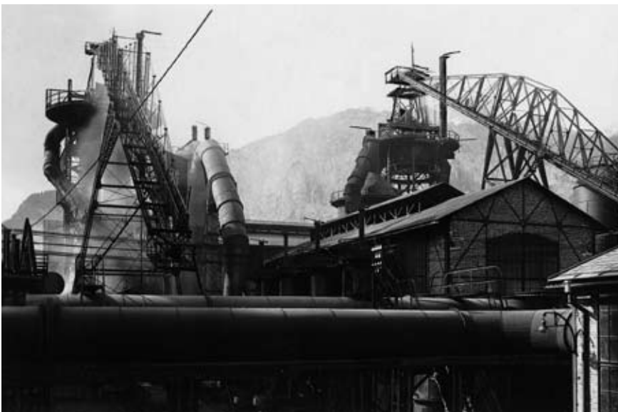
Abb. 3: Hochofenwerk in Eisenerz (Münichtal) 1928, Blickrichtung talauswärts. Ofen I (links) und II mit Gichtkränen; im Vordergrund Gichtgasleitungen. Aufnahme im Besitz von H. J. Köstler
