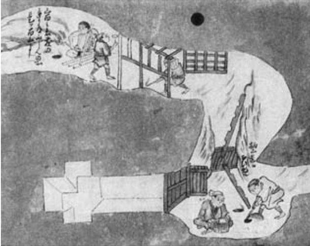
Abb.5: Zimmermanns- und Füllarbeit: links oben ein Zimmermann bei der Herstellung von Steigbäumen, rechts unten ein Bergmann beim Zusammenscharren der Erze mit einer Kratze
