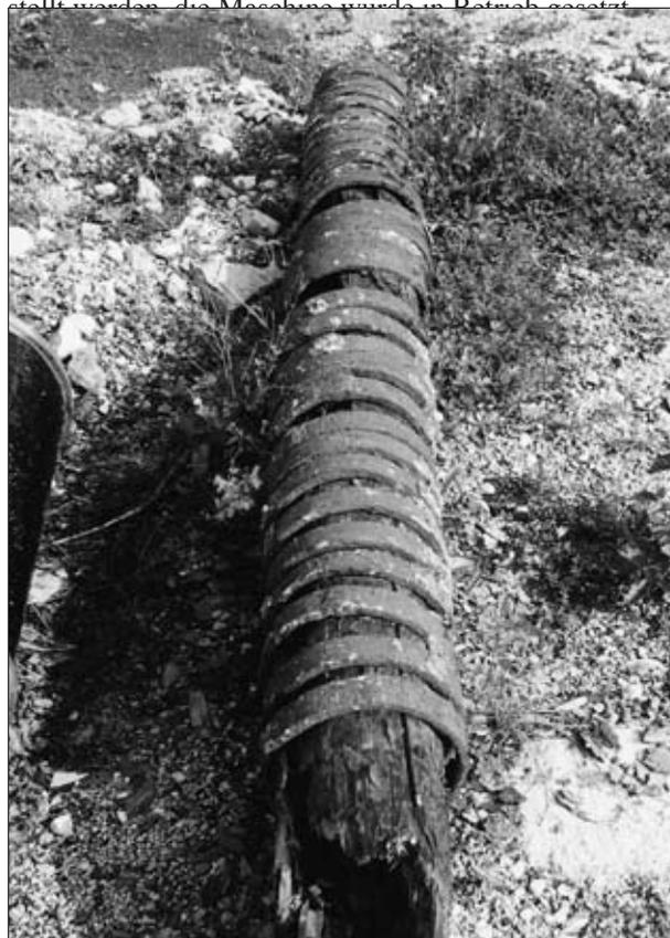
Abb. 1: Holzrohr einer Wassersäulenmaschine, Fuß der Halde des Rudolf Schachtes (Foto: Alfred Weiß, 1998).
