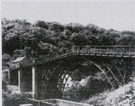
Bild 4: Die gusseiserne Brücke (Iron-Bridge), errichtet 1779 – 1781, im Gebiet der Stadt Telford, Shropshire, Mittellengland
