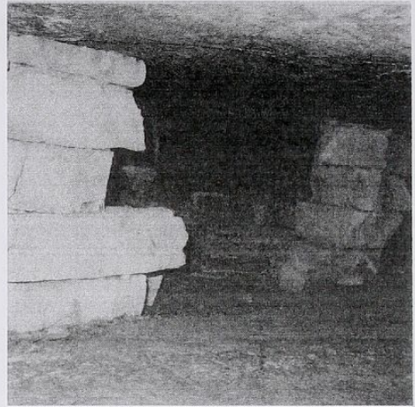
Abb. 3: Abstützung der Firste durch Gesteinsschichtung (Foto Friedrich Almer, Waidhofen an der Ybbs)
