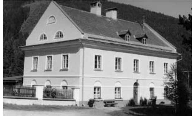
Abb. 6: Bundschuh. Gewerken- bzw. Verweserhaus als Teil des ehemaligen Hochofenwerkes „Franzenshütte“, erbaut 1847. 1862 begann die Gewerkschaft im Bundschuh mit der Errichtung eines steirischen Hochofenanlage („Franzenshütte“ (68)), doch „... haben sich (schon 1864) für die Zukunft dieses Werkes, welches im Begriffe stand, den Bau eines neuen Hochofens ... zu beenden, trübe Aussichten eröffnet, da die hohen Gestehungskosten der Erze und des Brennstoffes eine Concurrenz mit den benachbarten steirischen Werken ungemein erschweren“ (69). Der Hochofen (Abb. 7) konnte schließ-
