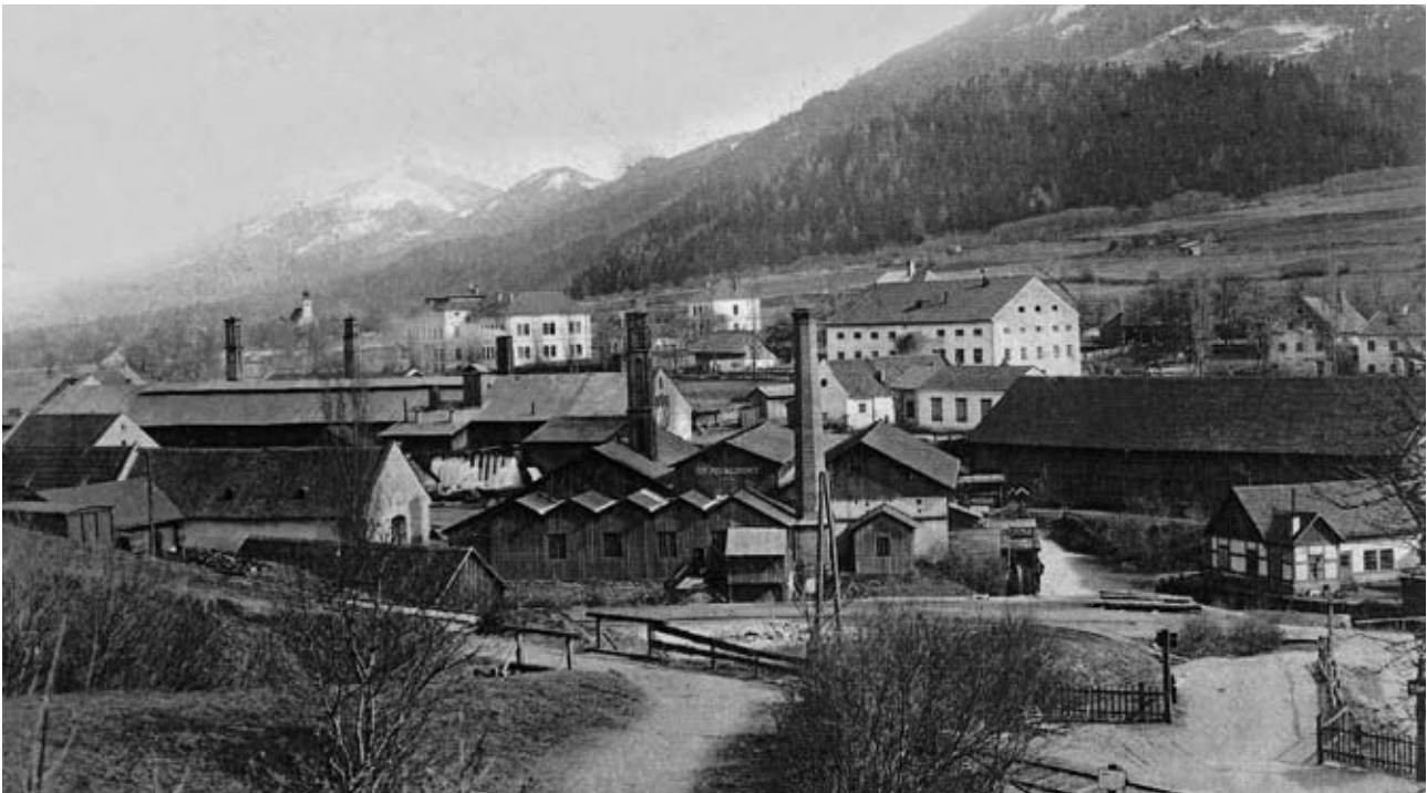
Abb. 5: Rottenmann um 1895/1900. Stahl- und Walzwerk der Firma Brüder Lapp, Eisenwerke in Rottenmann (Steiermark), vorm. Josef Pesendorfer's Erben. (Ein Gebäude in Bildmitte trägt noch die Aufschrift „Jos. Pesendorfers Erben“. Links der Bildmitte das 1890/91 erbaute (Landes-) Krankenhaus, dessen Anfänge auf eine Gründung Josef Pesendorfers zurückgehen; links des Krankenhauses Filialkirche hl. Georg in St. Georgen. Undatierte Fotografie im Besitz von H.J. Köstler.
