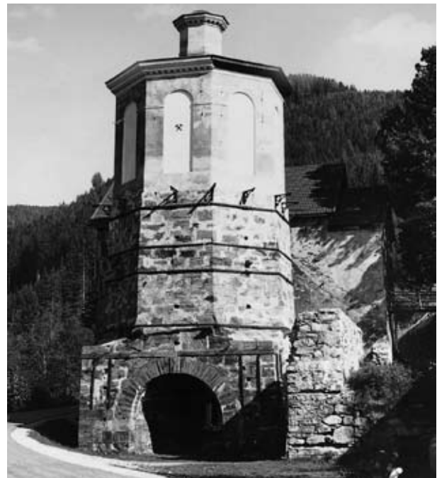
Abb. 7: Bundschuh (Gemeinde Thomatal bei Tamsweg). Hochofen, erbaut 1862, angeblasen 1867 und stillgelegt 1883. 1901-1903 letzte Schmelzkampagne; jetzt Teil des Nationalen Bergbau- und Hüttenmuseums bzw. des Ensembles „Franzenshütte“. Aufwändig hergestellt, 1984 die jeweiligen Jahresprodukti-
