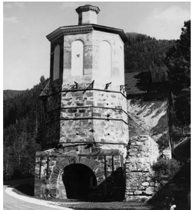
Abb. 7: Bundschuh (Gemeinde Thomatal bei Tamsweg). Hochofen, erbaut 1862, angeblasen 1867 und stillgelegt 1883. 1961-1963 letzte Schmelzkampagne; jetzt Teil des Nationalen Museums bzw. des Ensembles „Franzenshütte“. Aufwändig hergestellt, 1984 die jeweiligen Jahresprodukti-
