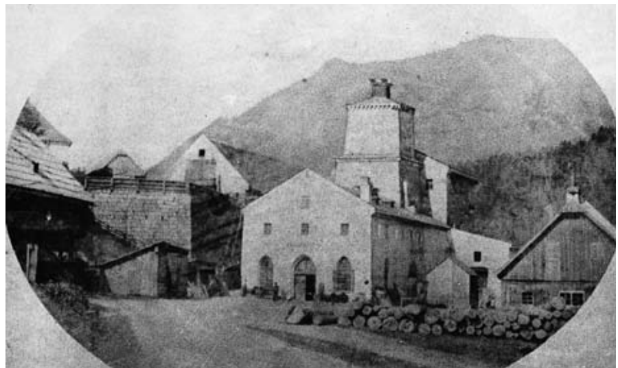
Abb. 9: Liezen. Hochofenwerk „ Amalienhütte “, erbaut 1853/54; Roheisenerzeugung 1854-1893. Links oben Kohlbarren, in Bildmitte Hochofen mit Aufzugshaus (hinten) und Hüttengebäude (vorne). Undatierte Fotografie (um 1880) im Besitz von H.J. Köstler.
