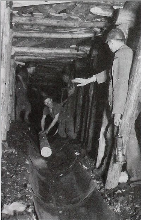
Bild 5: Holzlieferung im Streb in Fohnsdorf 1948 (Foto privat)
