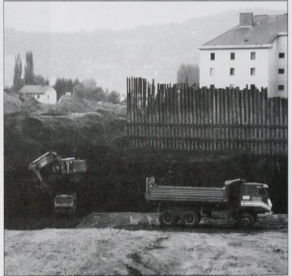
Bild 23: Restfeilergewinnung in Zangtal mit Spundwandtechnik am 11er-Hauspfeiler (Werksfoto GKB)
