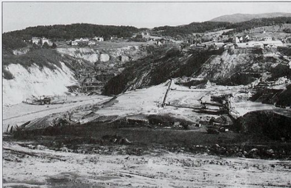
Bild 23: Restfeilergewinnung in Zangtal mit Spundwandtechnik am 11er-Hauspfeiler (Werksfoto GKB)
