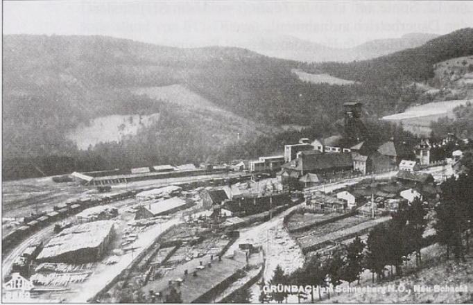
Bild 1: Werksanlage Grünbach mit dem 627 m tiefen Hauptförderschacht dem „Klaus“ - oder „Neuschacht“ mit 6,1 m lichten Durchmesser (alte Ansichtskarte, um 1950, Sammlung Dipl.-Ing. Mag.iur. Alfred Weiß)
