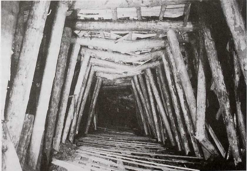
Bild 27: Ausgekohlter, verlegter Abbaustreifen vor dem Abwerfen am Karlsschacht 1985 (Werkfoto GKB)
