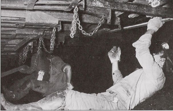
Bild 12: Vorpfänden des Zeltweg Schlepprahmenausbaues A4 im EW 130 - Walzenstreb bei der SAKOG 1964 (Werksfoto ÖAMG)
