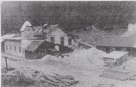
Die Aufbereitungsanlage in Haufenreith um 1926. An der Längsfront das turmartige Transformatorhaus sowie die typischen Absetzbecken für den anfallenden Schlamm. Die Erzwagen wurden über eine Rampe in das Obergeschoß der Anlage gezogen. Im äußersten rechten Bildteil das Wasserschloß am Ende des Wassergrabens, über welchen ursprünglich das Aufschlagwasser für die Maschinen zugeleitet wurde. Die gemauerten Gebäude sind heute nur noch als Ruinen erhalten.
